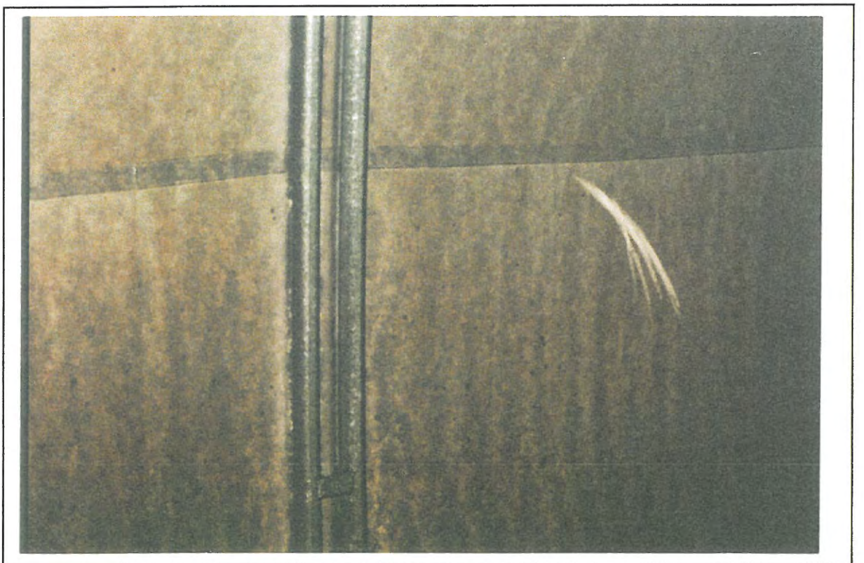
FOTO 15 Holmestrandtunnelen 1/4 97: Tunnelduk etter vask. Kun der vaskehjulet var i direkte kontakt med duken er det rent.
