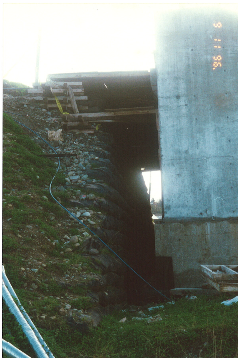
Bilde 15: Armert jord inn mot landkar for forbelastning og reduksjon av jordtrykk
