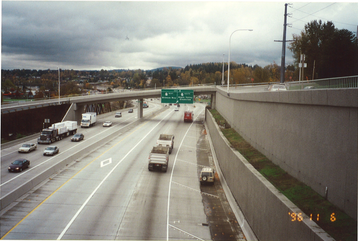
Bilde 8: Støttekonstruksjon utført med jordnagling og plasstøpt betongfront
