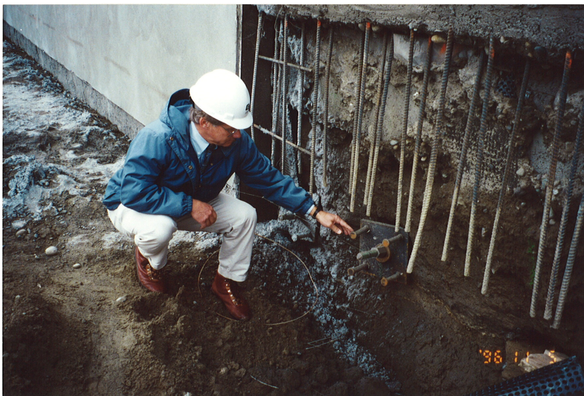
Bilde 2: Gordon Denby viser stålplaten montert på naglehodet
