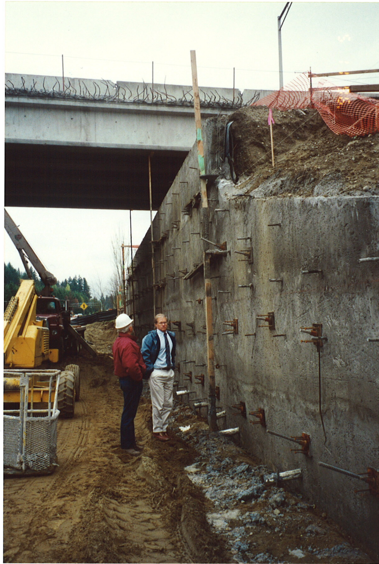
Bilde 6: Jordnaglingsmur med naglehoder før endelig plasstøpt betongvegg bygges utenpå
