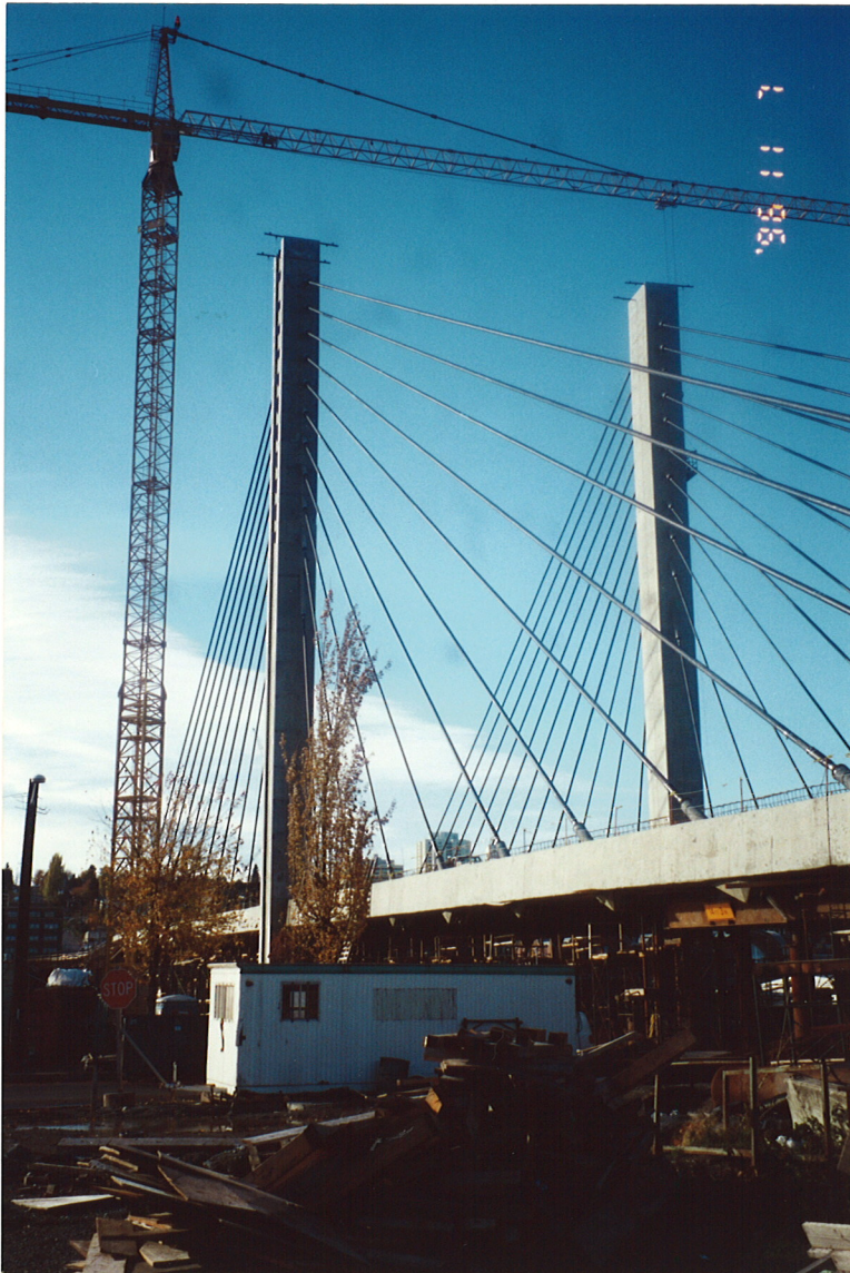
Bilde 16: Bru under bygging
