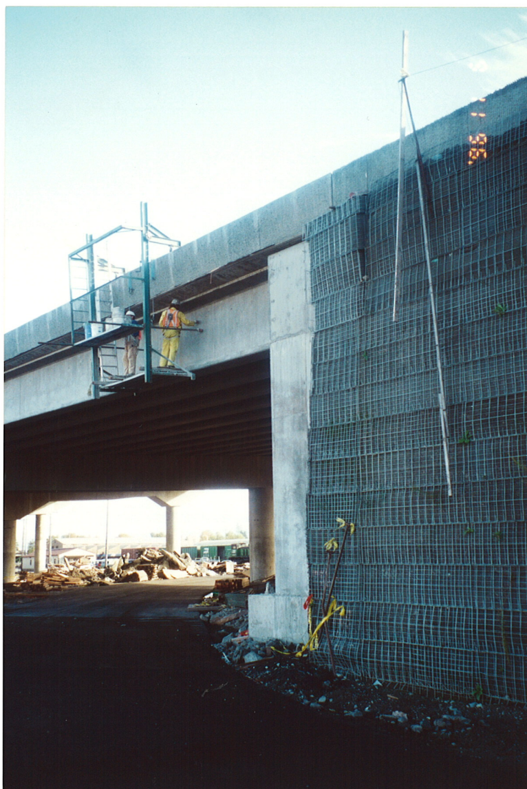
Bilde 18: Armert jord konstruksjon bygd med "Welded-wire" systemet
