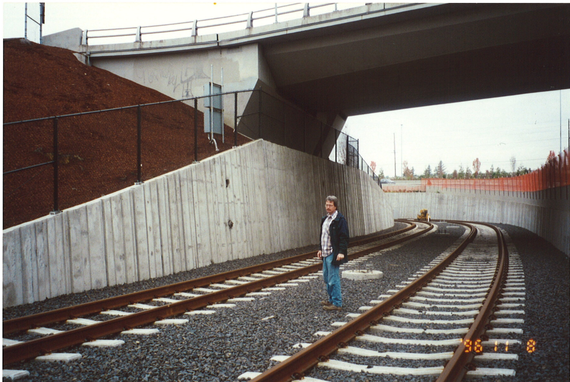
Bilde 26: Instrumentert jordnaglingsmur foran brulandkar
