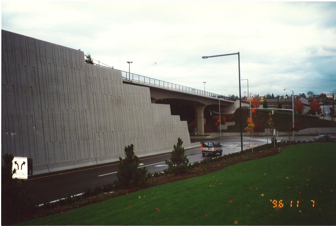
Bilde 14: Støttekonstruksjon utført med jordnagling
