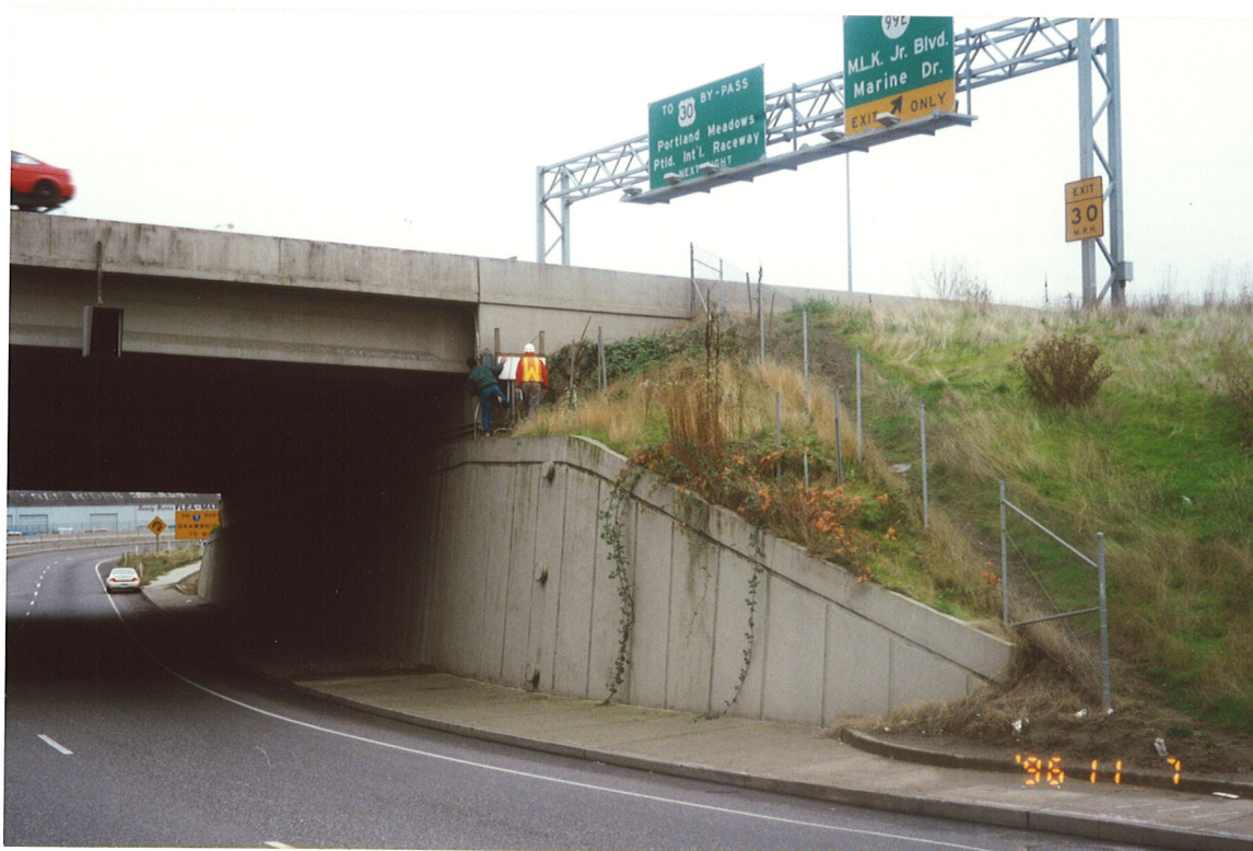
Bilde 22: Ferdig konstruksjon med måleskap på toppen
