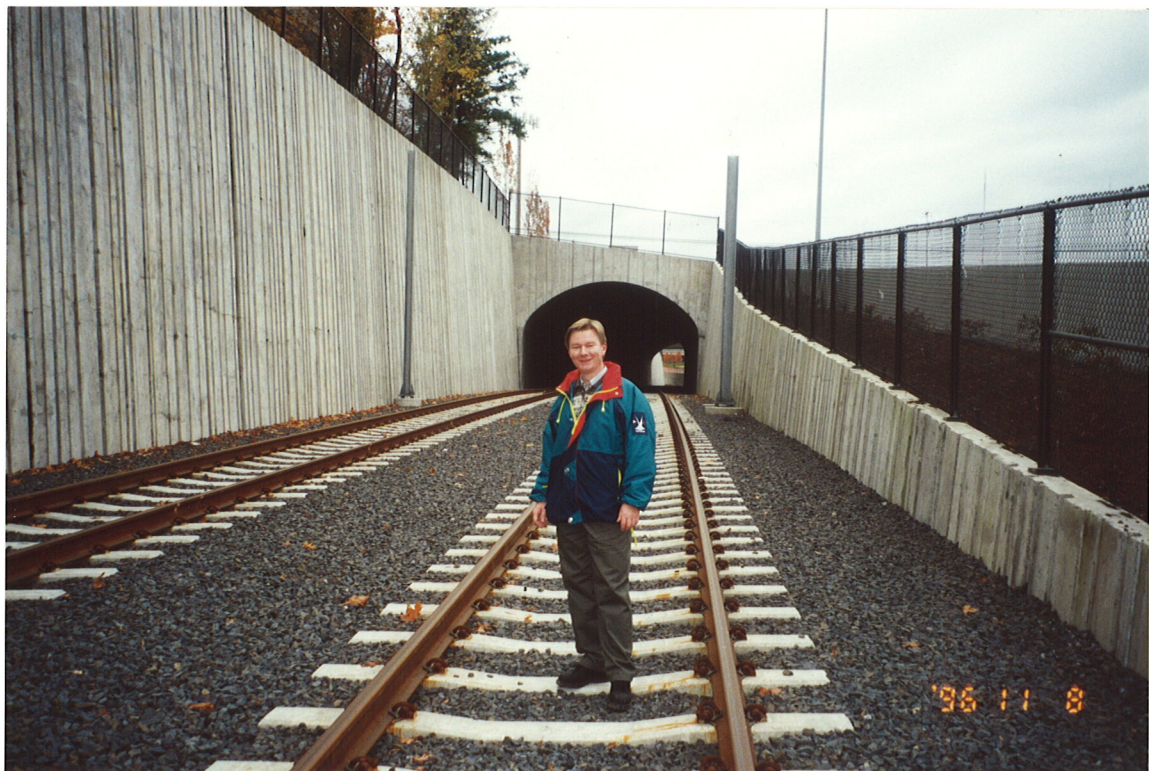
Bilde 27: Jordnagling i skjæring foran inngang til "cut and cover" tunnel
