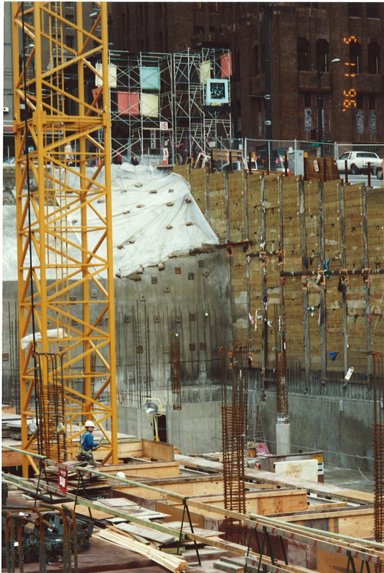
Bilde 7: Jordnagling og berlinervegg brukt ved bygging av nytt konserthus i Seattle sentrum
