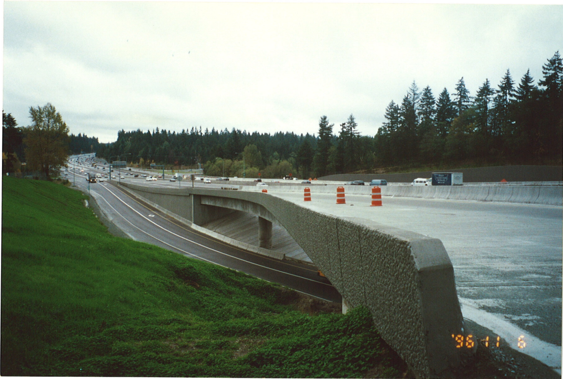
Bilde 12: Støttekonstruksjon med jordnagling
