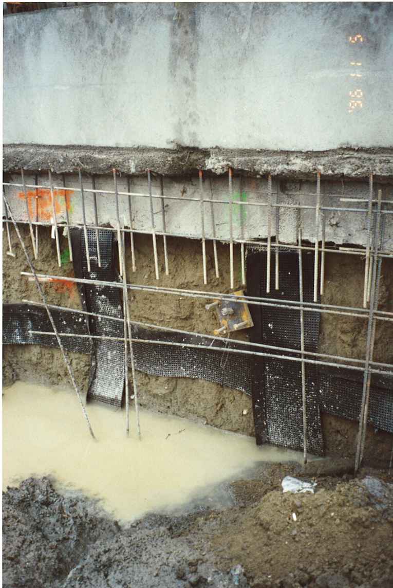
Bilde 3: Drensstriper av geosyntet
