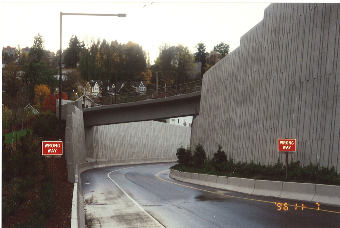
Bilde 13: Jordnagling brukt på begge sider i en skjæring
