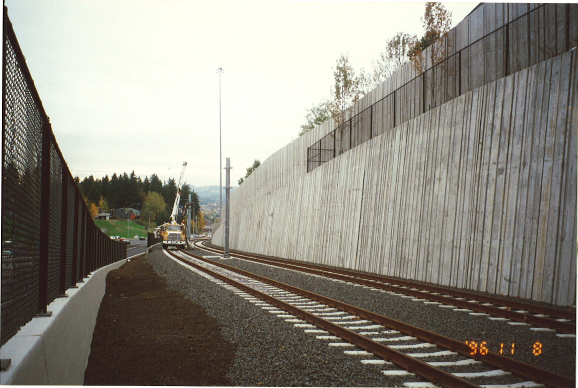
Bilde 28: Mur i 2 høyder, på nedre del er det brukt jordnagling, på øvre del armert jord
