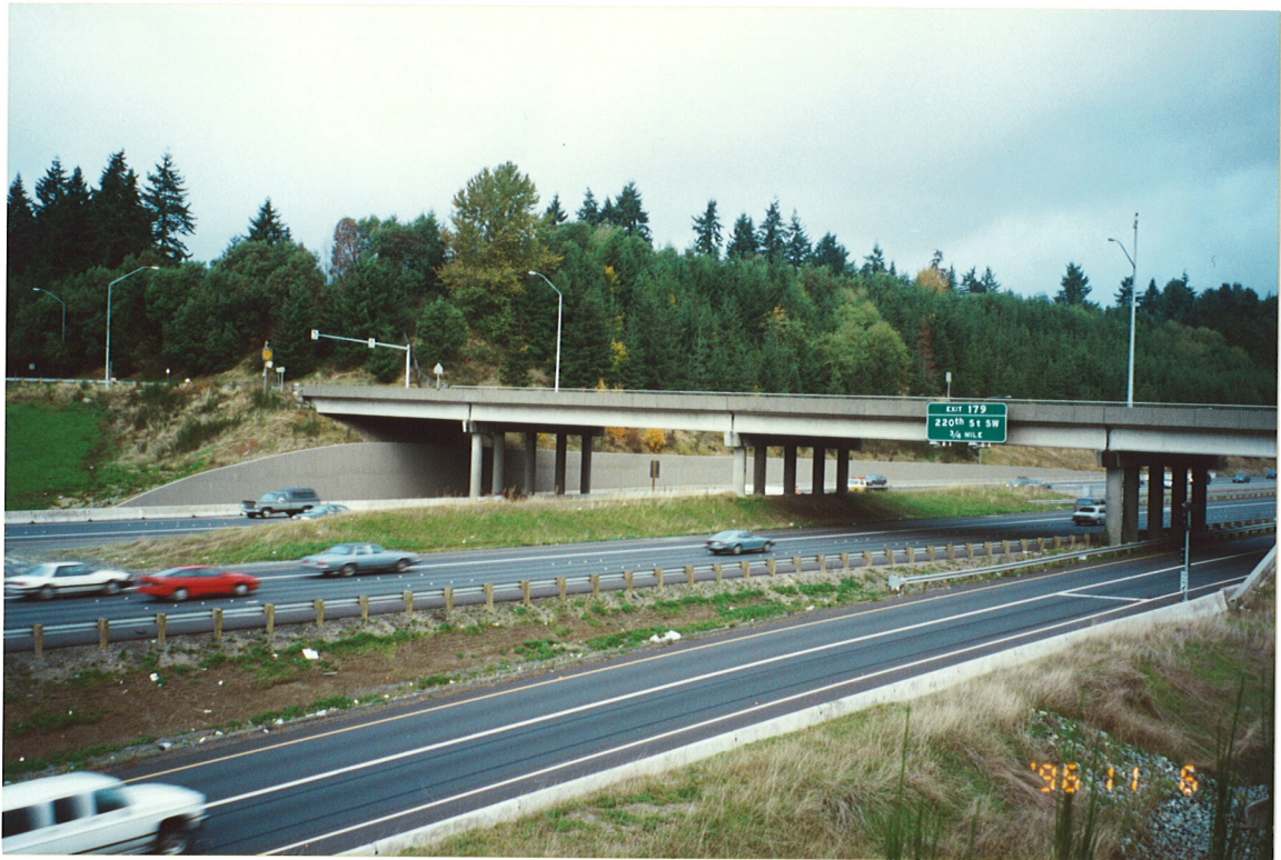
Bilde 10: Jordnaglingsmur under bru (utvidet med ett felt)
