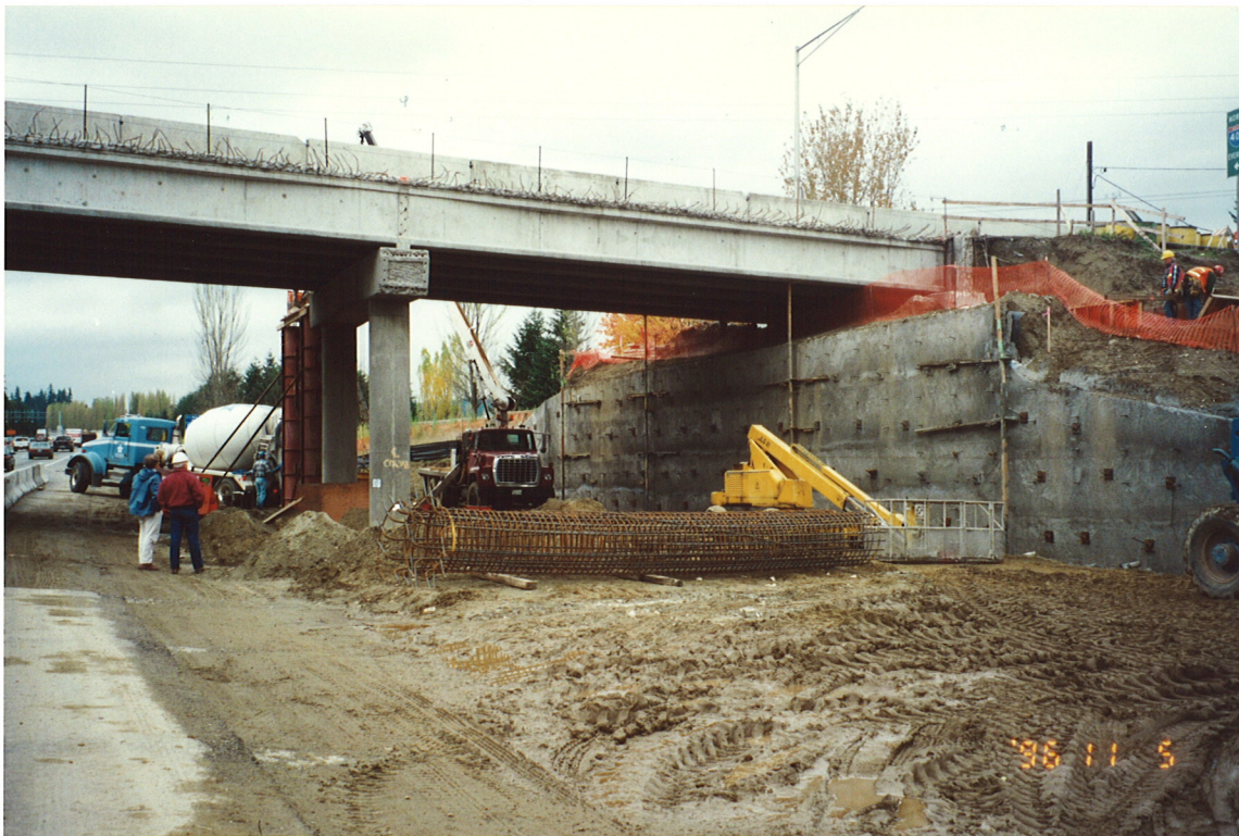
Bilde 5: Jordnagling brukt ved utvidelse med ett felt under en bru
