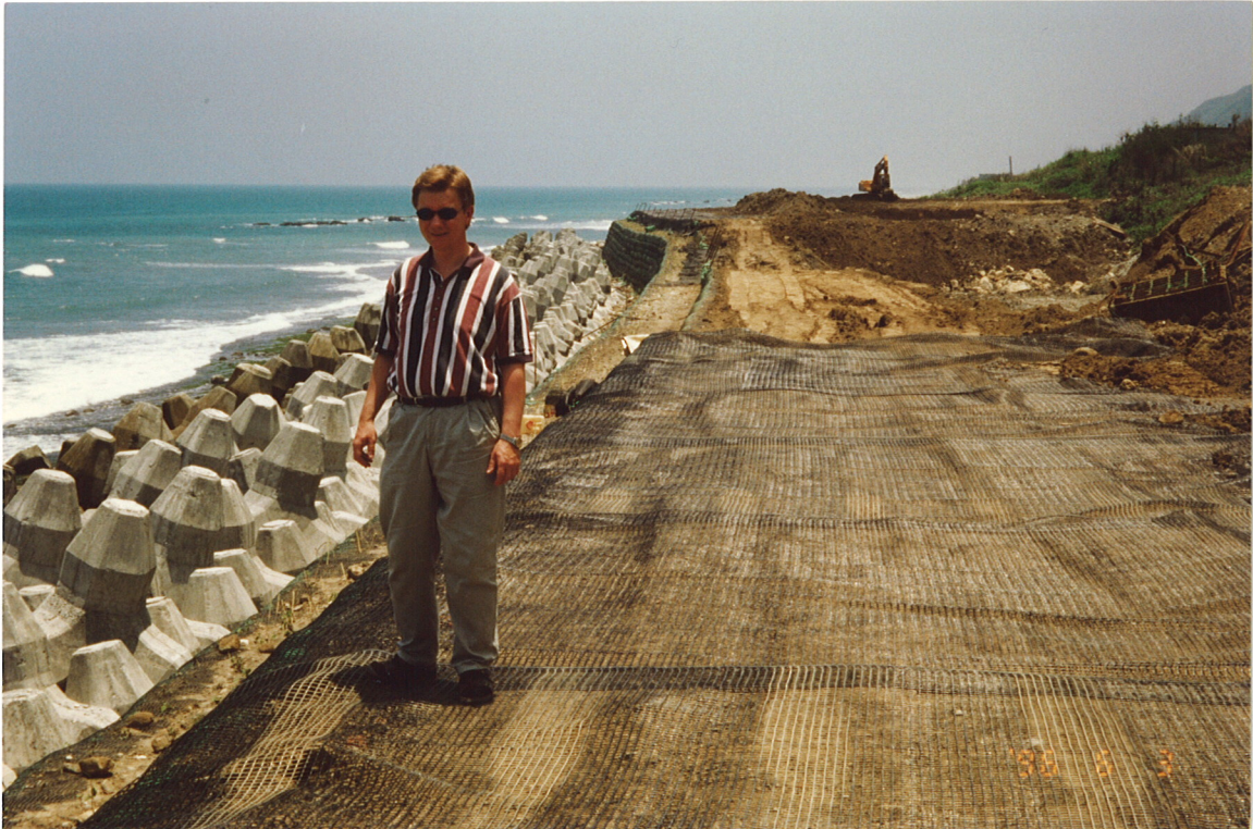
Bilde 9 Armeringen ble lagt med overlapp ca. 30 cm. Representanten fra Veglaboratoriet studerer prosjektet
