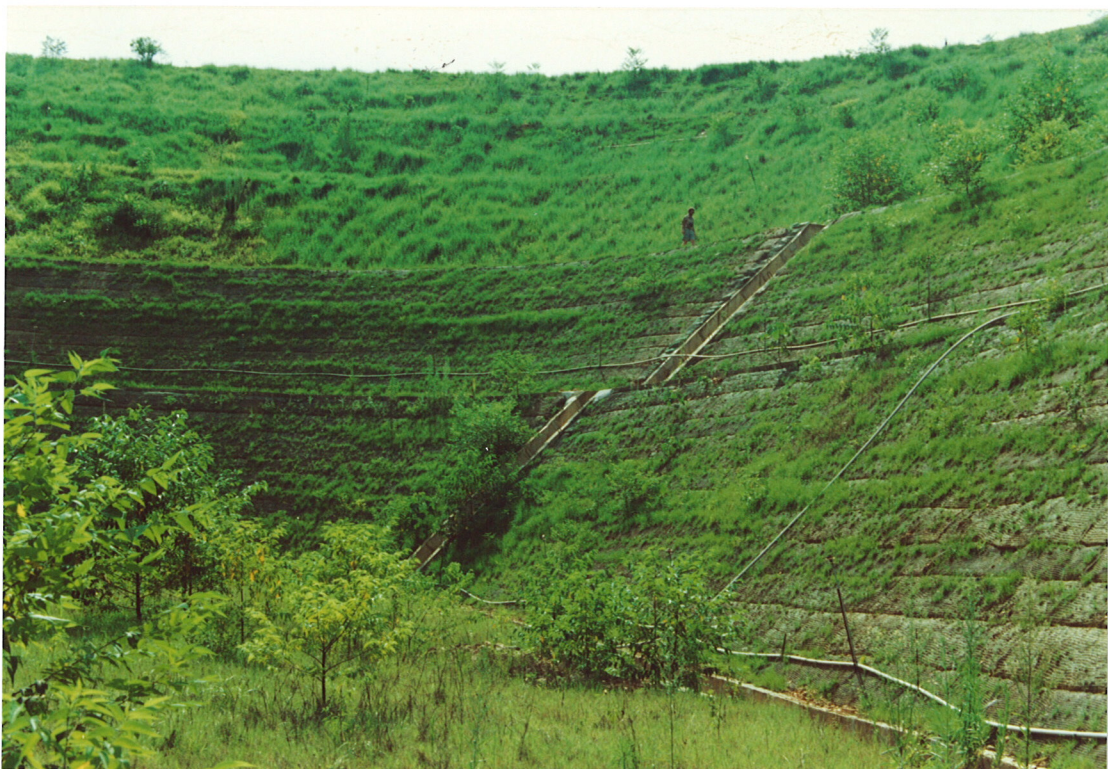
Bilde 40 Vannslanger er utlagt for etablering av vegetasjon med kunstig vanning
