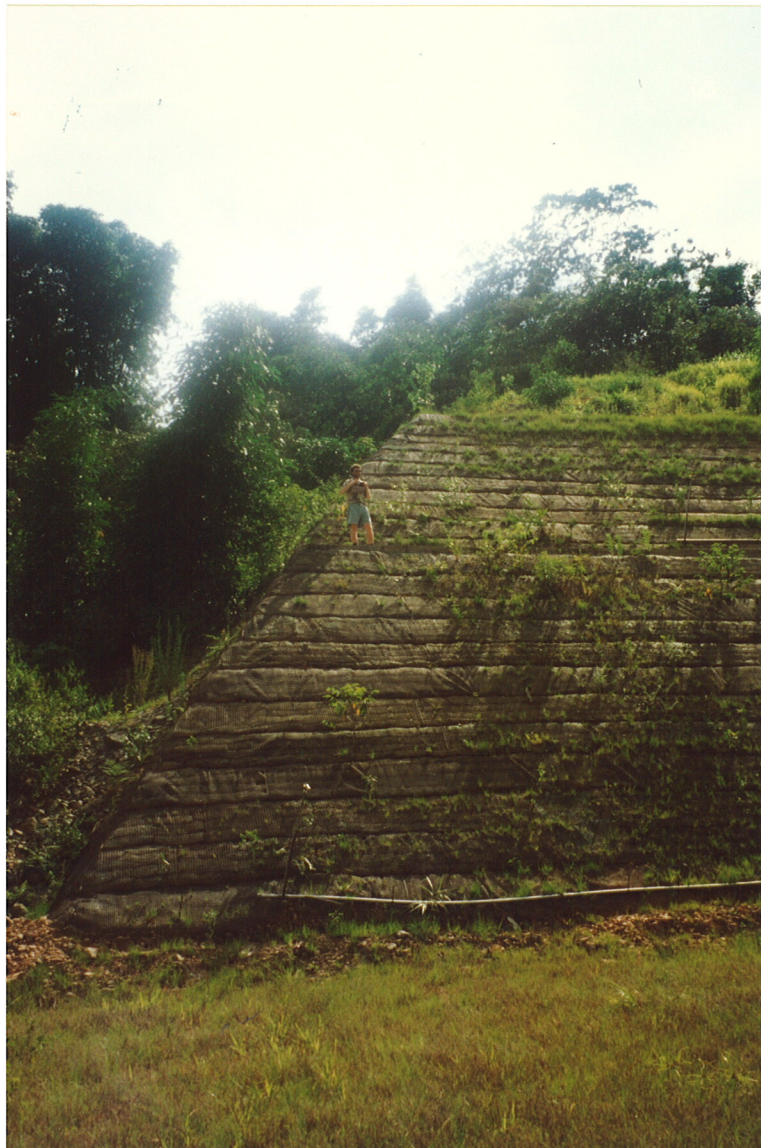
Bilde 38 Kun de to nederste terrassene med totalt 12 m høyde var armert. Hovedarmering var Telegrid 150 og sekundærarmering Telegrid 55
