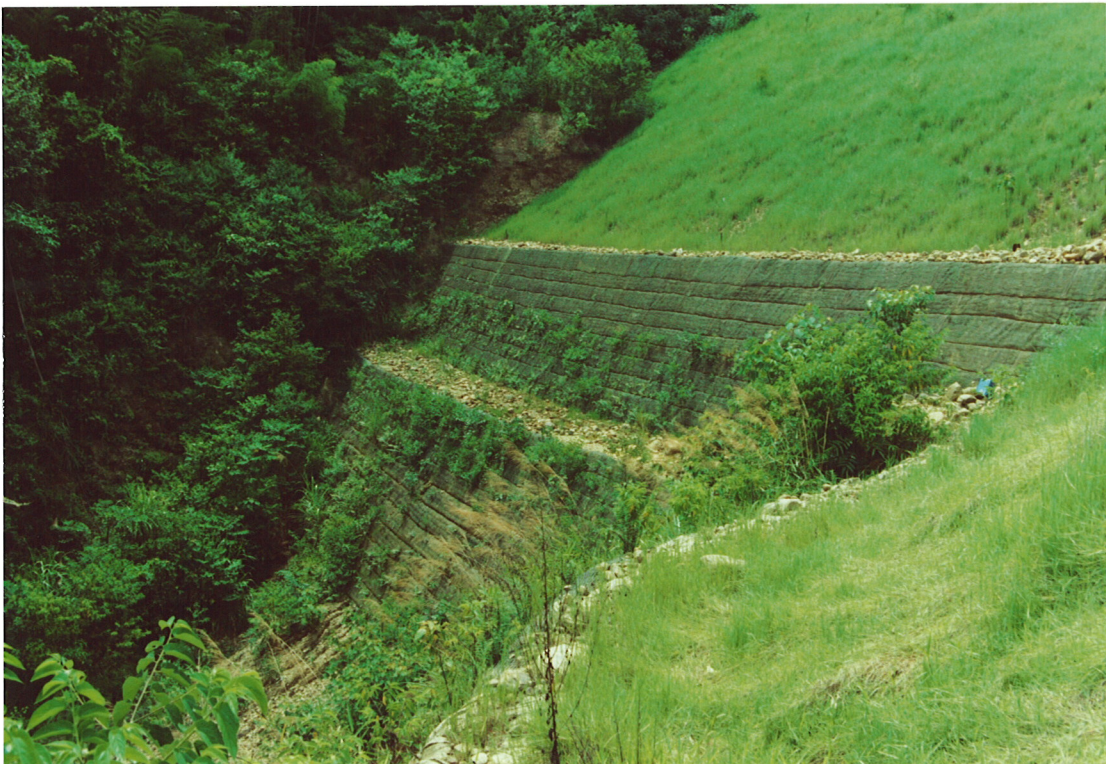
Bilde 43 Bratt, armert skråning med Telegrid jordarmering
