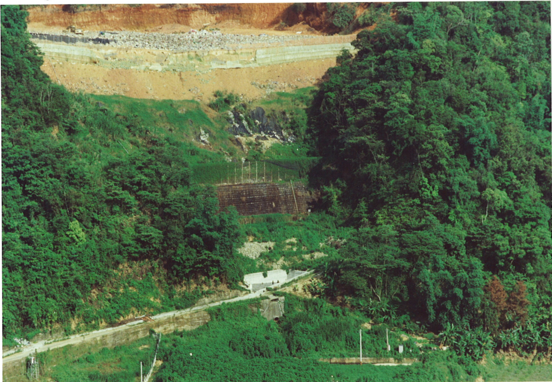
Bilde 45 En utrast plasstøpt betongmur øverst på bildet. Midt på bildet er det en jordarmert konstruksjon
