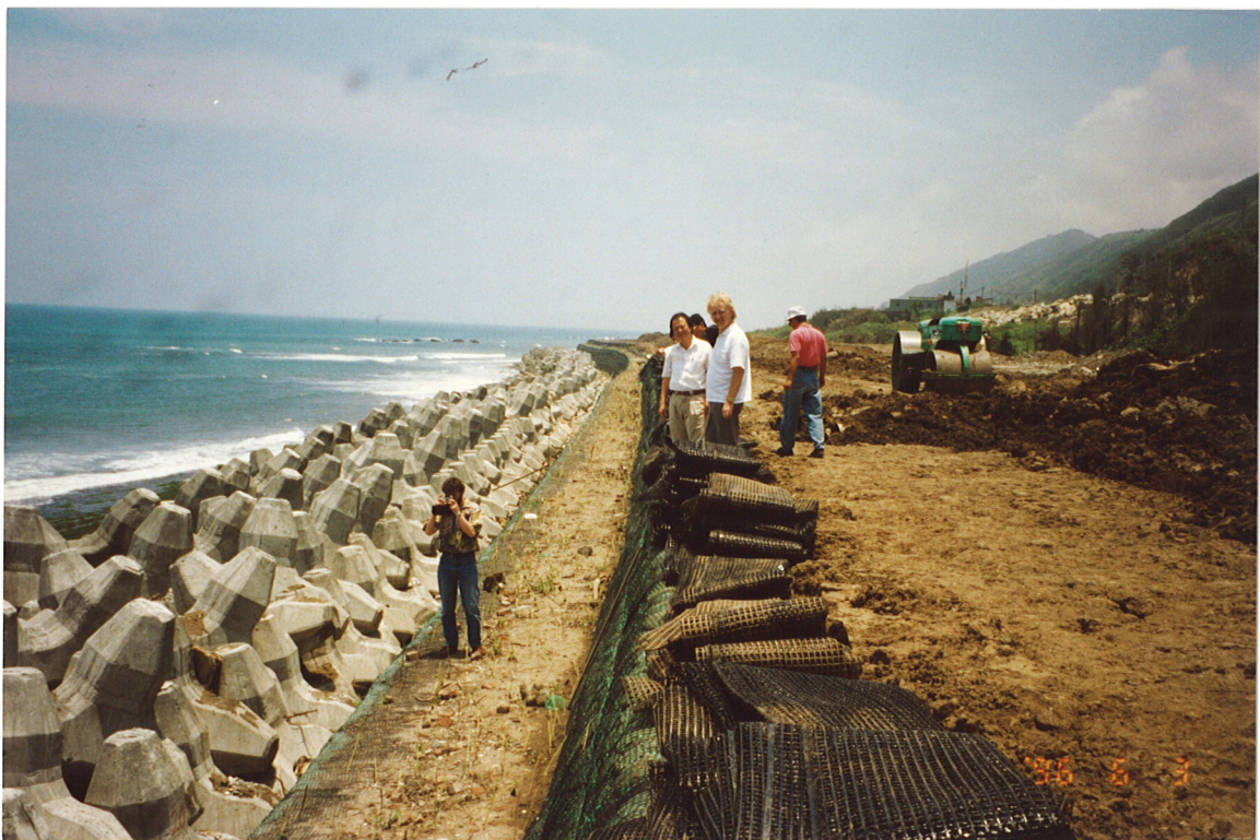
Bilde 8 Ruller med armering i forgrunnen. I bakgrunnen står komprimeringsutstyret, en ca. 6 t valse
