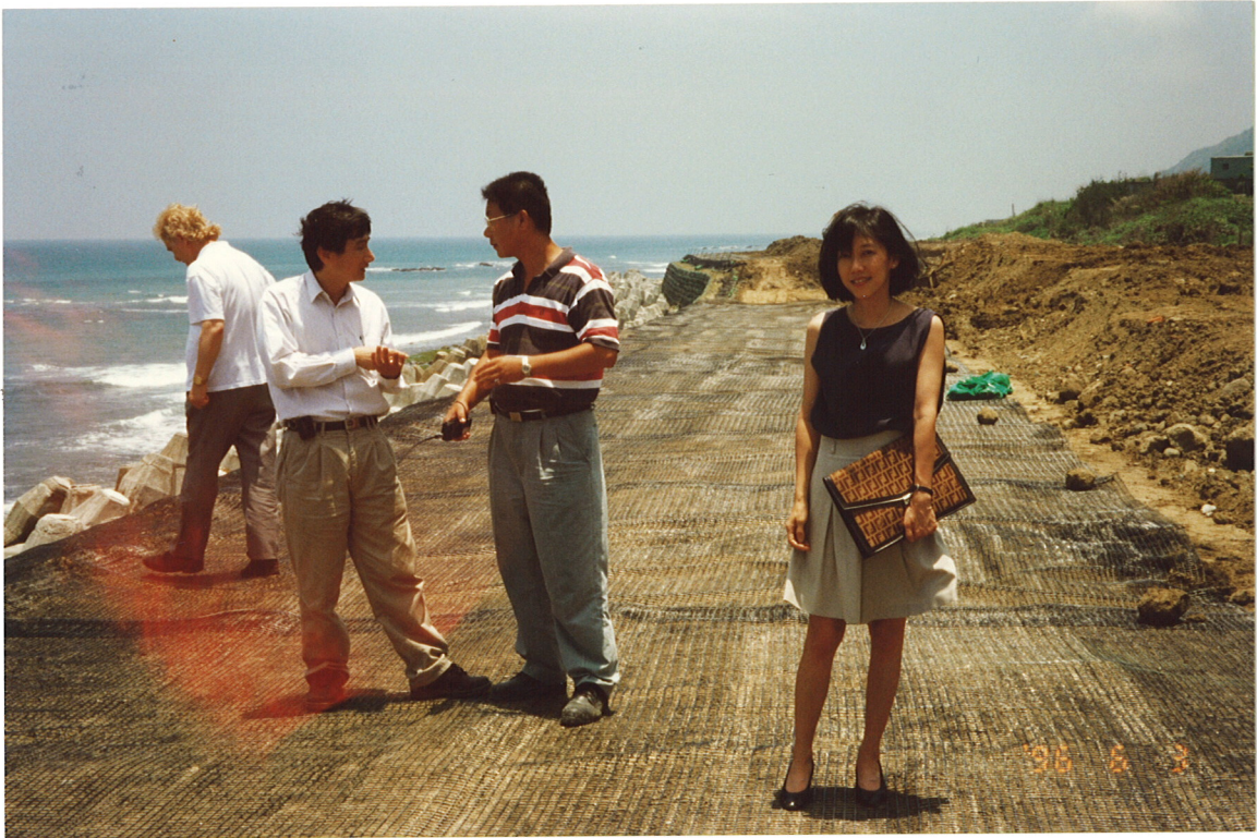
Bilde 7 Armeringen ble strammet godt opp. På bildet er tolken og guiden vår Maureen Fang
