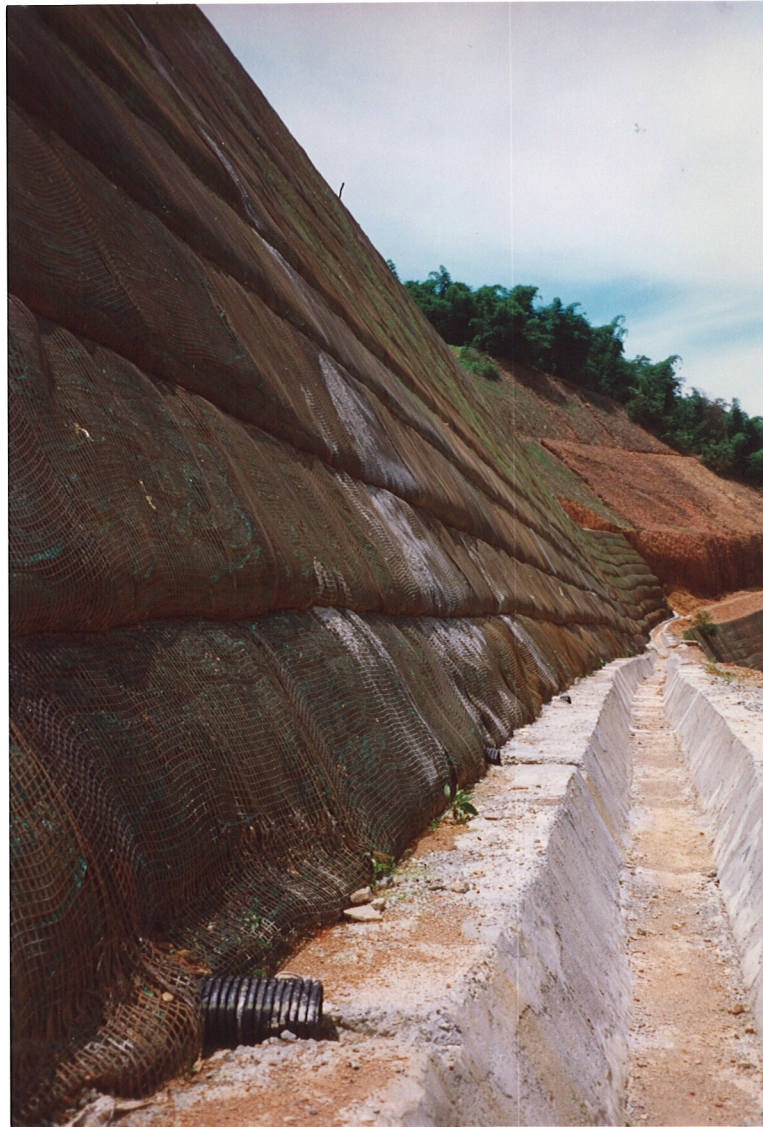
Bilde 29 Plastrør gjennom fyllinga i tillegg
