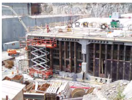
Forskaling av endeskott
