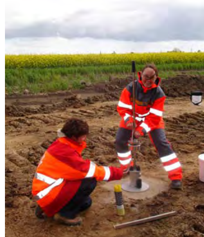
Feltarbeid på Lolland – undersøkelse av undergrunnsmaterialer med fallodd
