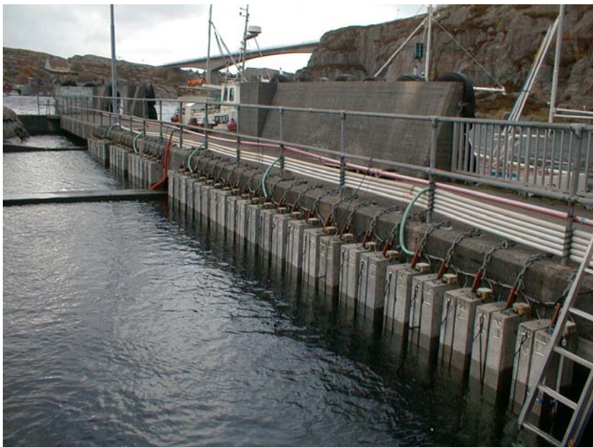
Bildet viser bjelkeelementer opphengt i en kai på Solsvik utenfor Bergen
