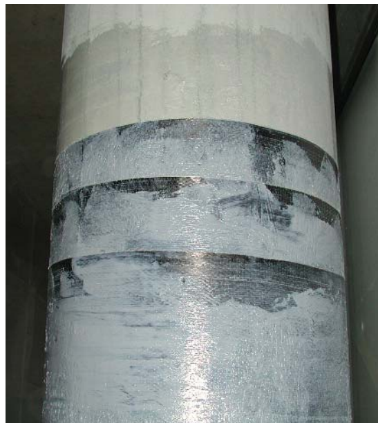
Bildet viser karbonfiberforsterkning på en søyle (fra Postgirobygget)
