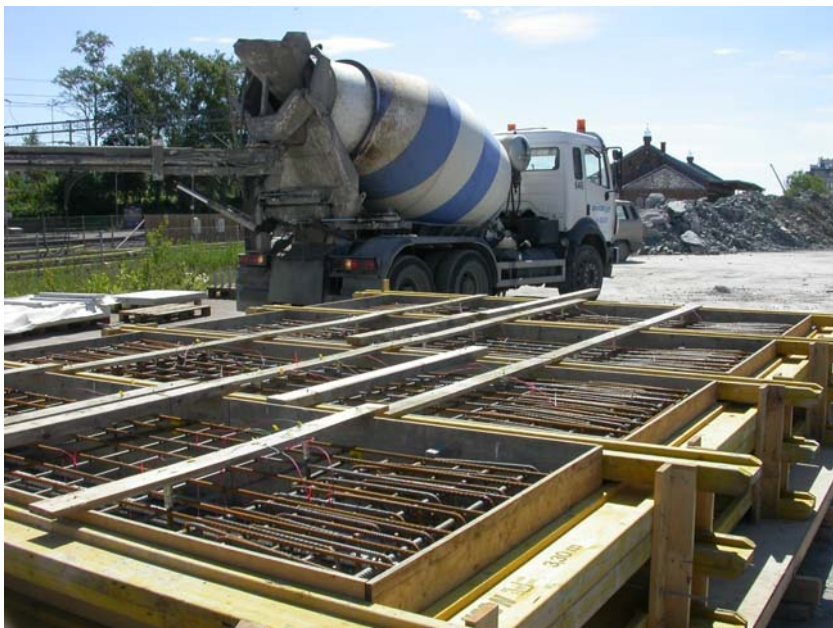
Bildet viser støping av store armerte elementer til brannprøving, betongen var tilsatt 2 kg polypropylen (PP) fiber per m 3
