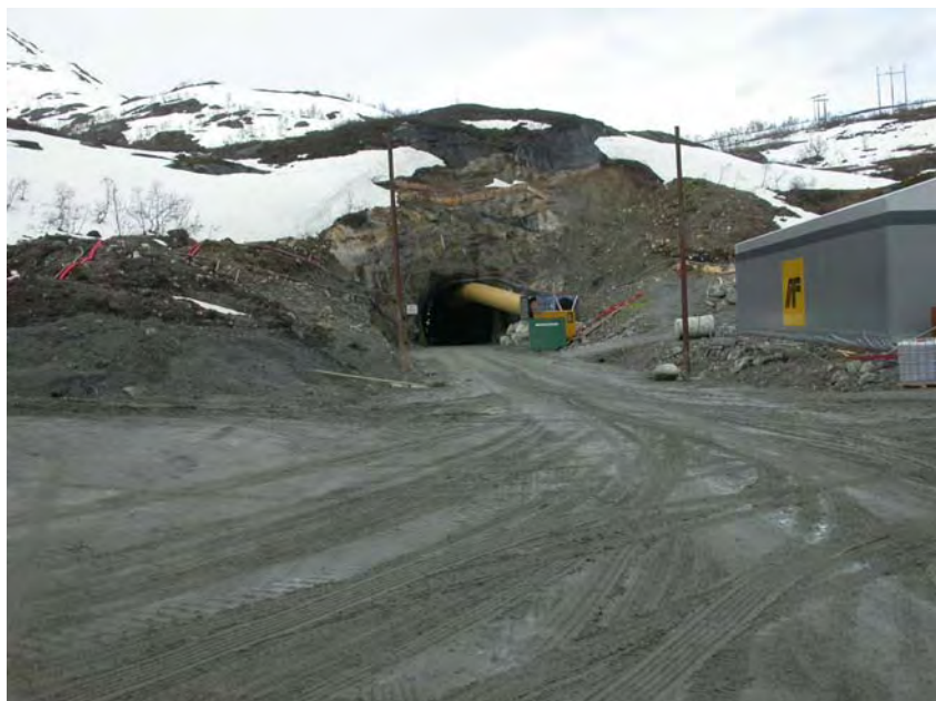
Figur 1: Sjørdaltunnelens påhugg fra østsiden under drivingen
