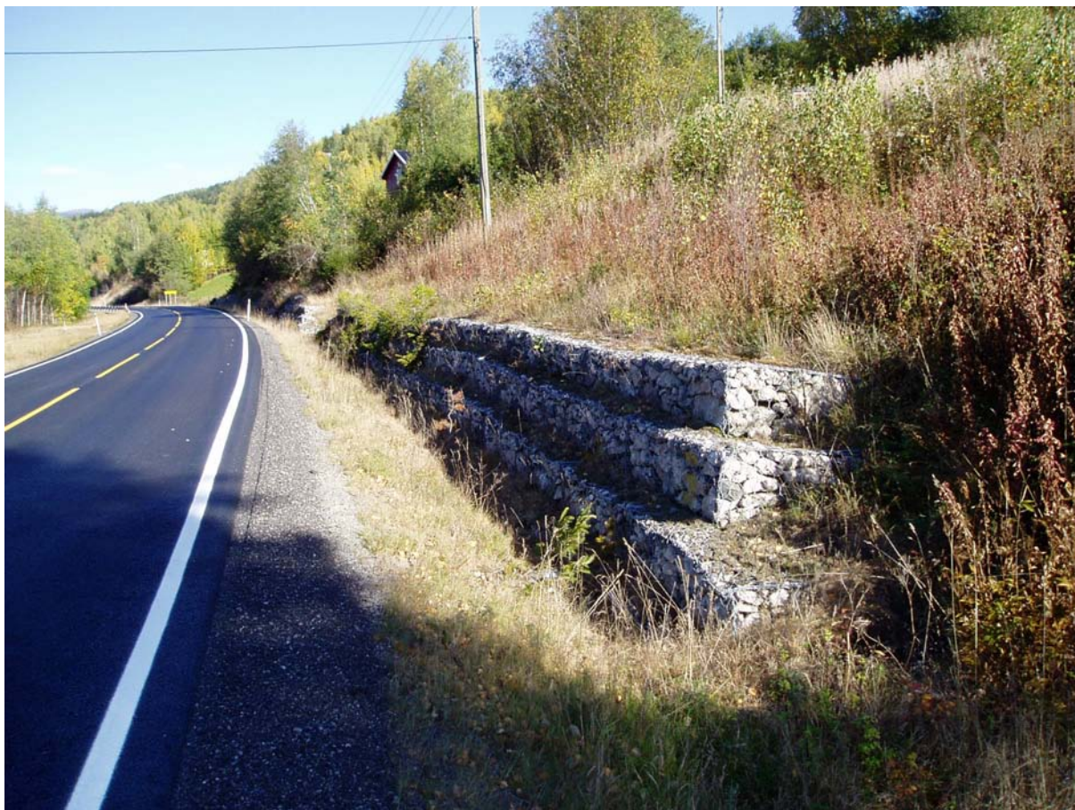
Gabionmurer ved km 7,64 – 7,77.
