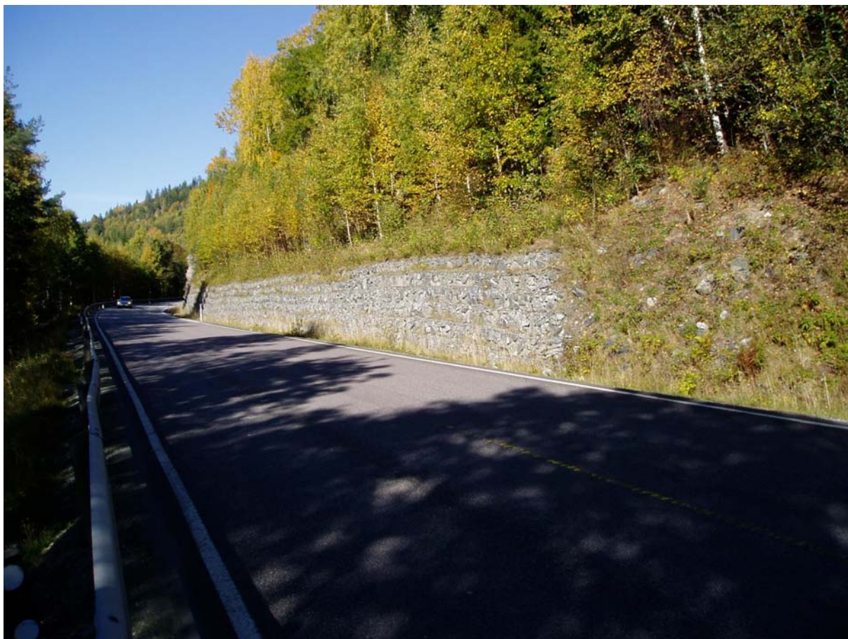
Oversiktsbilde av mur.
