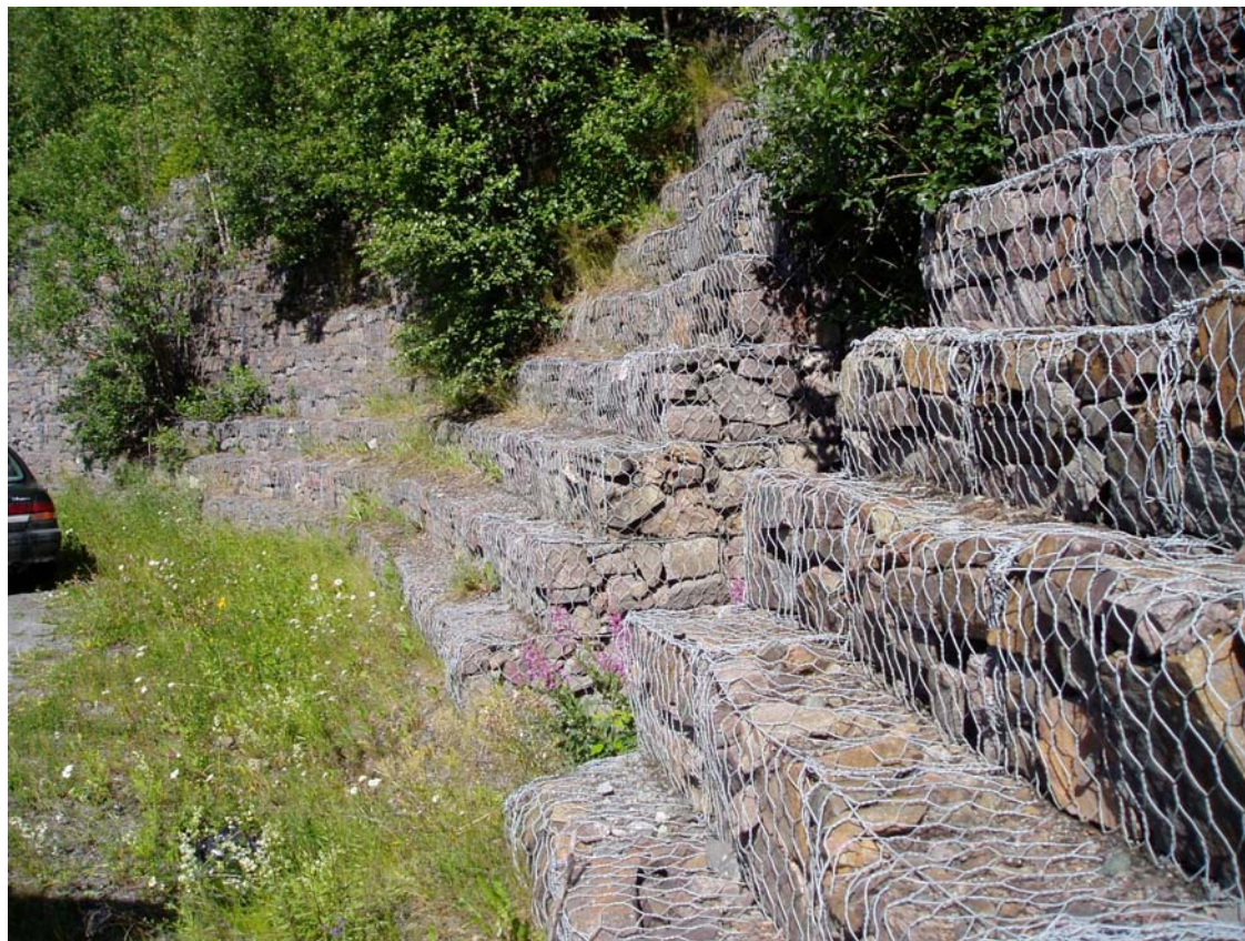
Nærbilde av midtpartiet på muren.
