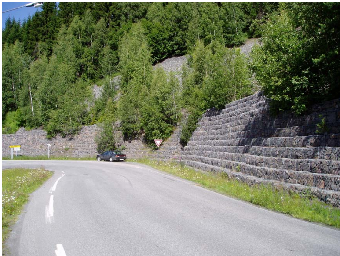
Gabionmur sett fra Åsvegen
