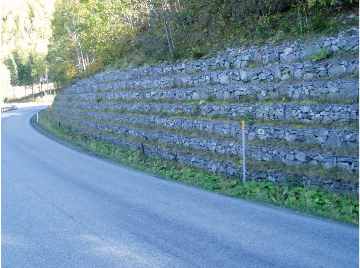
Parti av mur i Haugensvingen
