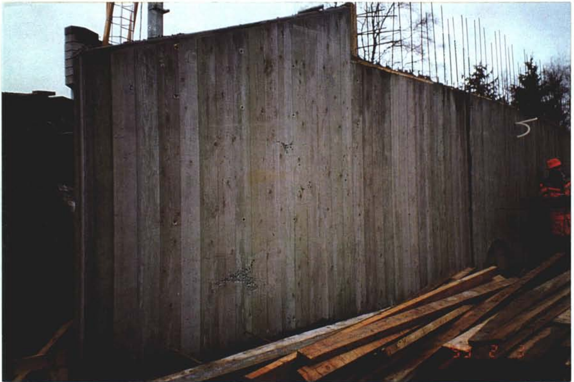
Foto 3 Søndre/nedre vegg, østre parti, som ble vibrert. Som helhet viste denne delen dårligste resultat
