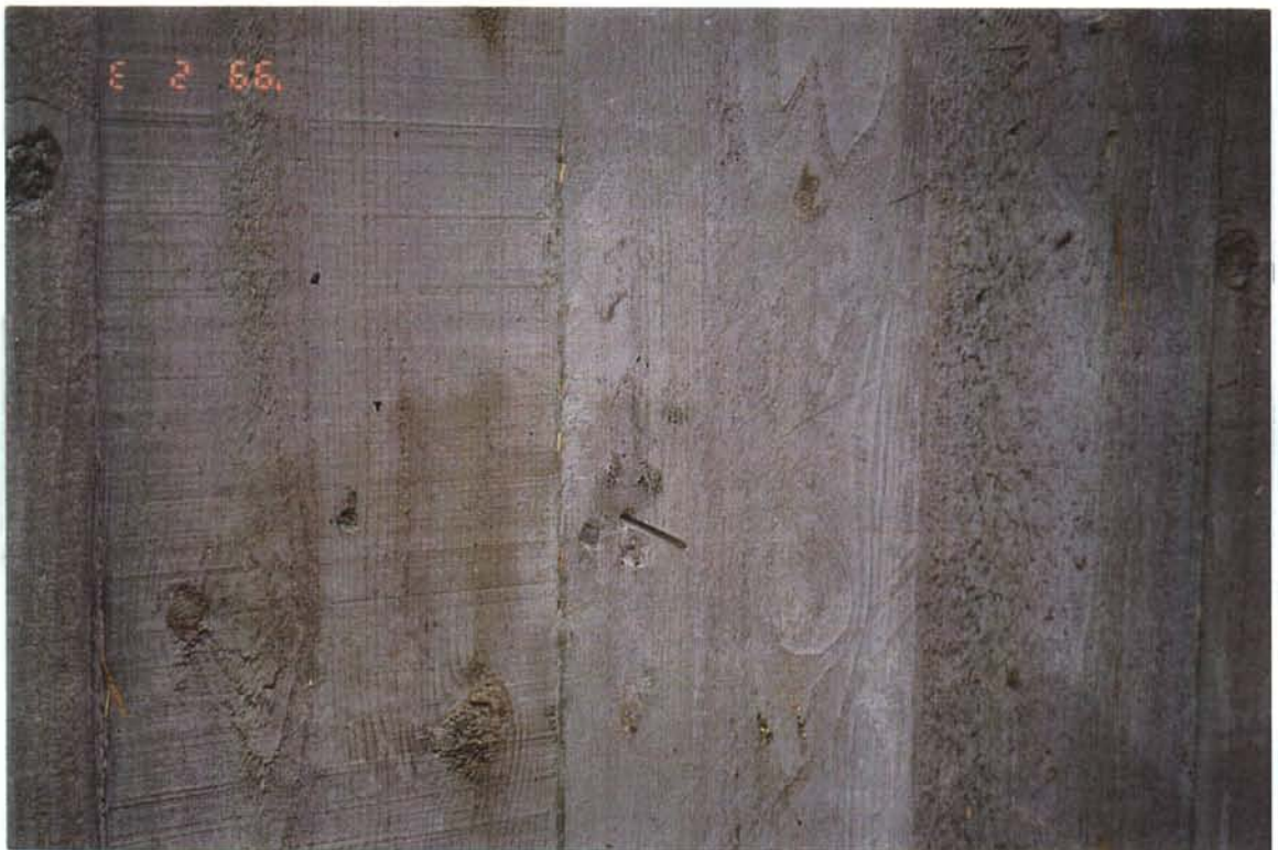
Foto 8 Armeringsstol av plast, perfekt innstøpt
