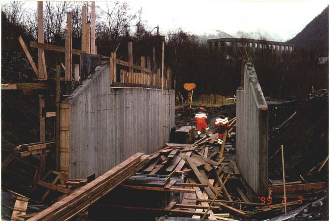
Foto 1 Kulvertveggene etter avforming. Sett mot øst
