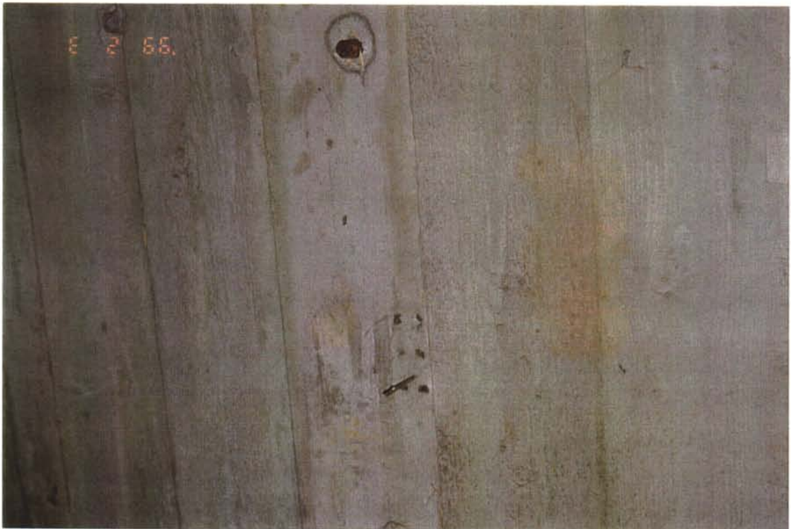
Foto 10 Sjøholt armeringsstol perfekt innstøpt
