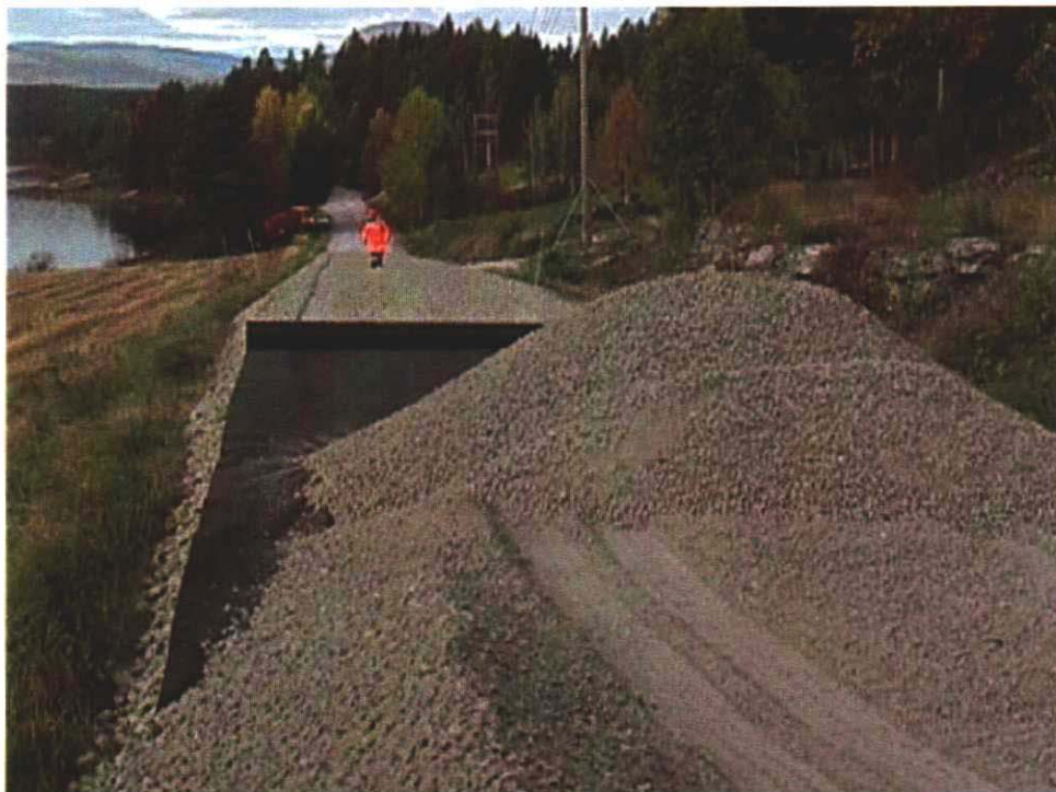
Skumglassgranulat ferdig utlagt. Fiberduk og pukk under utførelse.
