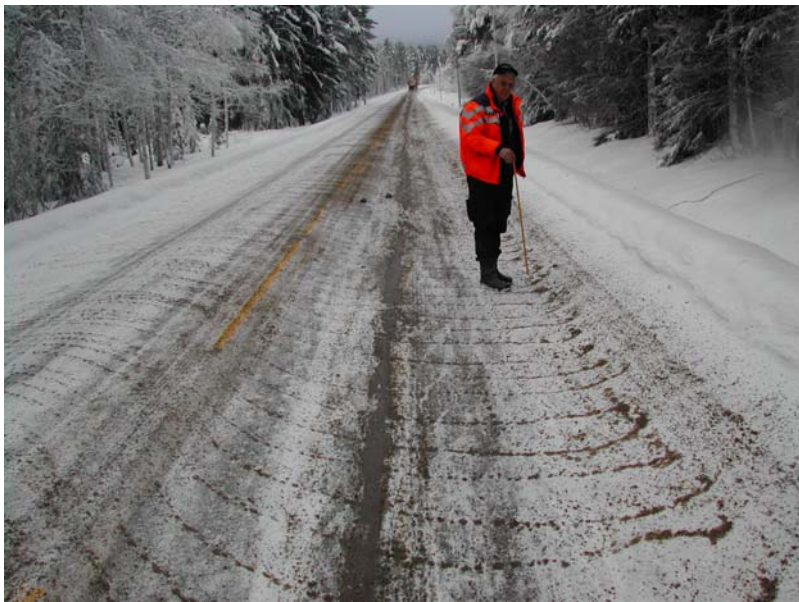
Figur 4.5: Strøbilde etter Tynsetbilen. Innstilt på 3 meter
