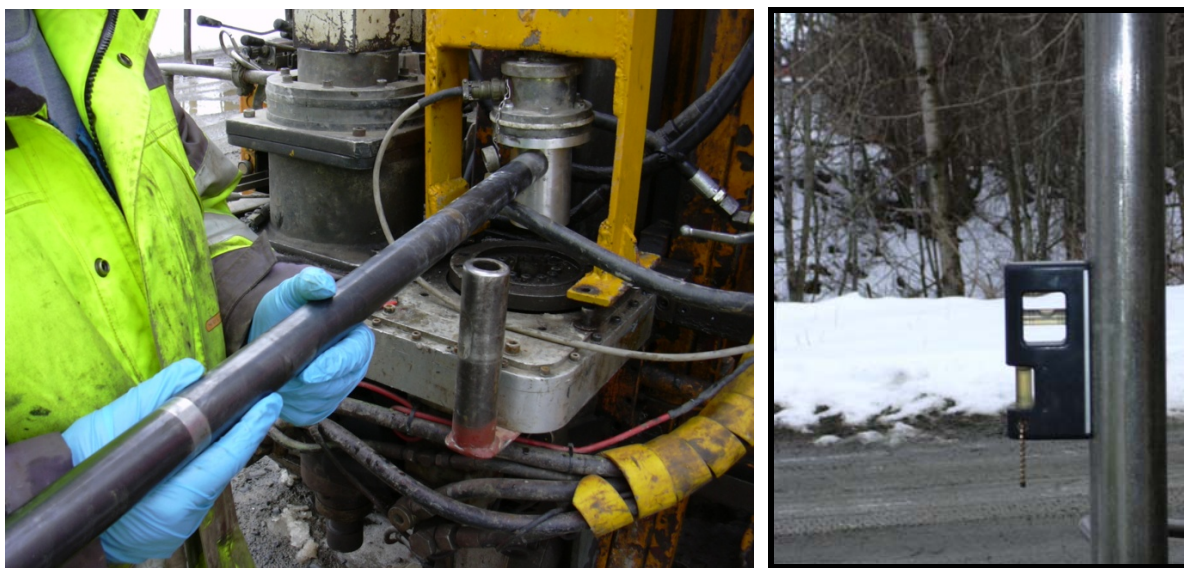
Figur 5.7. Avlesning av nullpunkt, Geotech sonde (t.v.) med eldre registreringsutstyr. Vertikalitetssjekk før sondering (t.h.).
