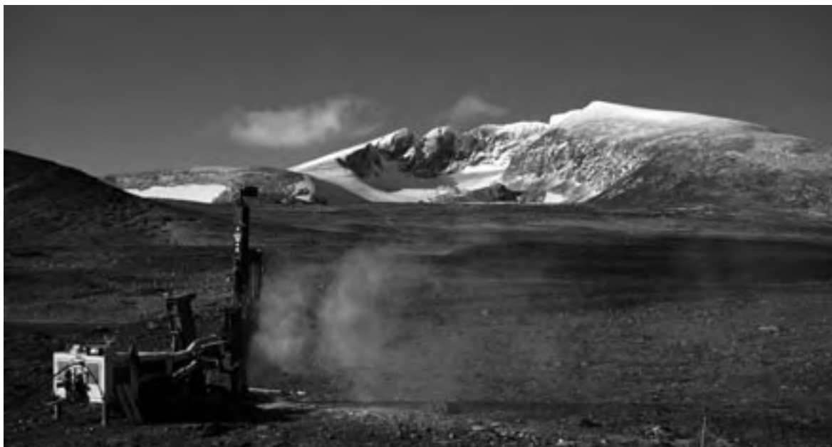
Figur 2: Boring av et 9 m dypt borehull (DB2) ved Snøheim på Dovrefjell, oktober 2001. Borehullet er lokalisert 1481 m o.h. (Foto: Ketil Isaksen).
