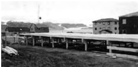
Figur 11: Fundamenter og dekke 1. etg., Sverdrupstasjonen.
