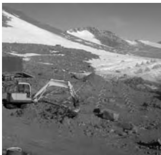
Figur 14: Fundamentene for garasjebygget satt ut, før søyler er montert.
