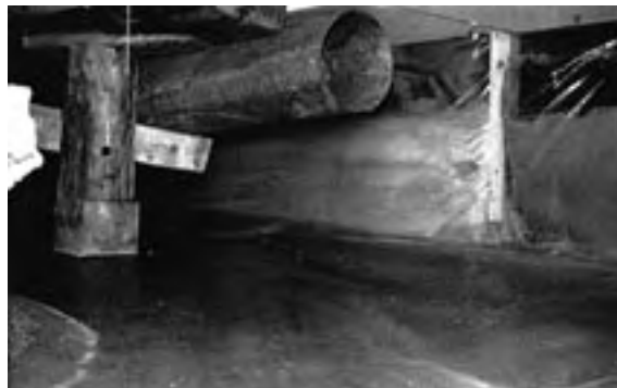
Figur 2: Kjølesystem og fundamentering for det Gamle sykehuset
