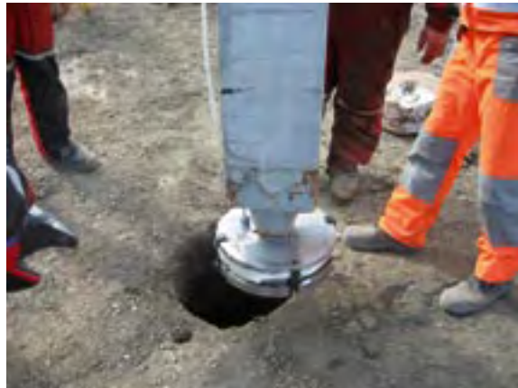
Figur 8: Betongpel med lastcelle.
