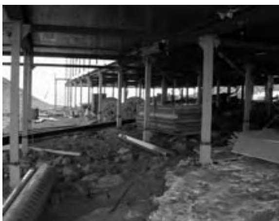
Figur 12: Fundamenter og stålkonstruksjoner under forskningsstasjonen.
