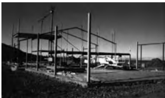
Figur 16: Plate på fylling for lagerbygg på fylling i sjø.
