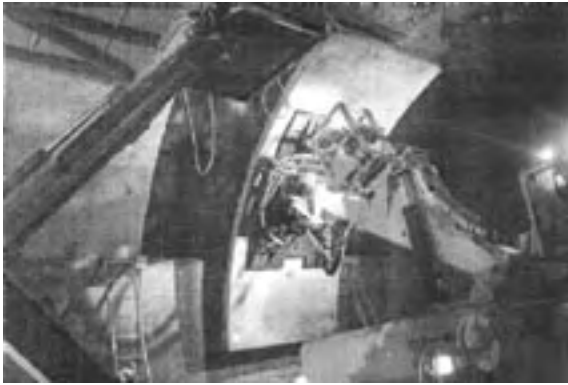
Montering av isolerte betongelementer for vann- og frostsikring
