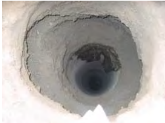
Figur 6: Bilde ned i boret hull for peleinstallasjonen.
