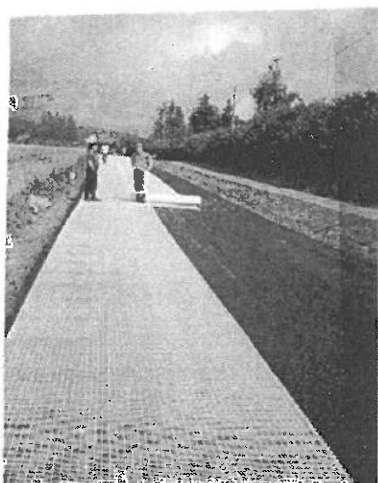
Utlegging av nett
