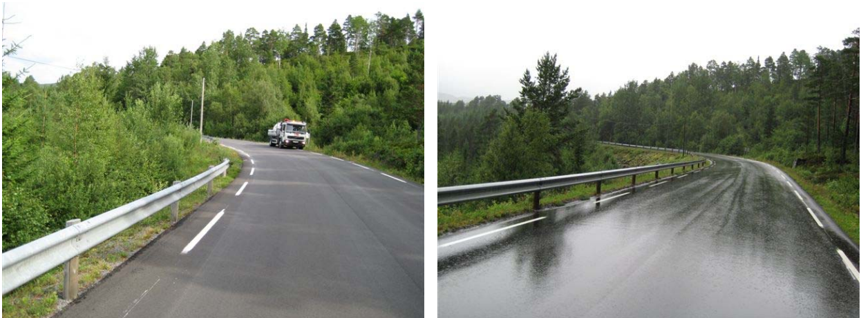
Fig. 15. Eksempel på betydning av siktrydding. Sikt gjennom kurven før og etter fjerning av vegetasjon.
