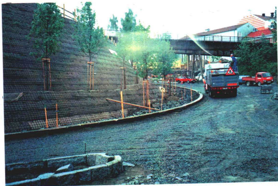
Sprøyting av frøblanding.
