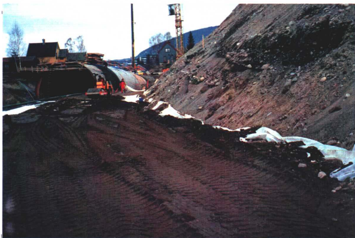
I bakkant fylling, mot terrenget, ble der lagt fiberduk opp til kontakt med overliggende, drenerende masser.
