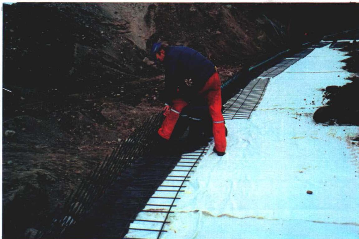
Armeringsduken er lagt ut. Del av frontduken fra underliggende lag synes under arm.korg. Armeringskorgene tilpasses.
