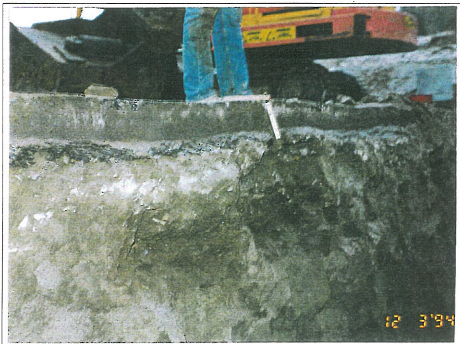
Bilde 1: Oppgraving E 6 Hp 12 km 1,640
