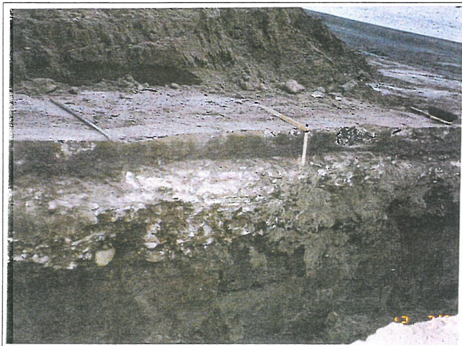
Bilde 2: Oppgraving E 6, Hp 12 km 1,865
