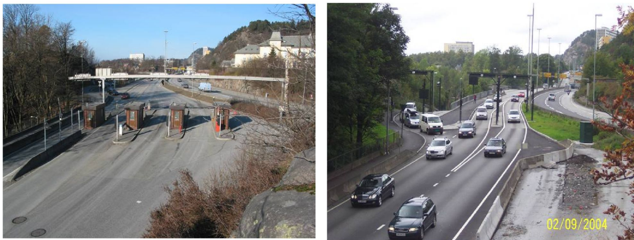
Figur 6.1. Sandviken bomstasjon i Bergen i før- og ettersituasjon
