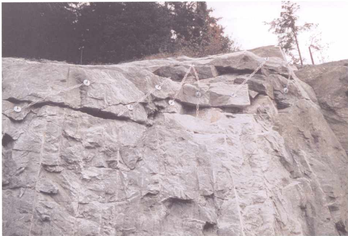
Bolting av løse blokker med fjellbånd. (Foto: K. B. Pedersen)
