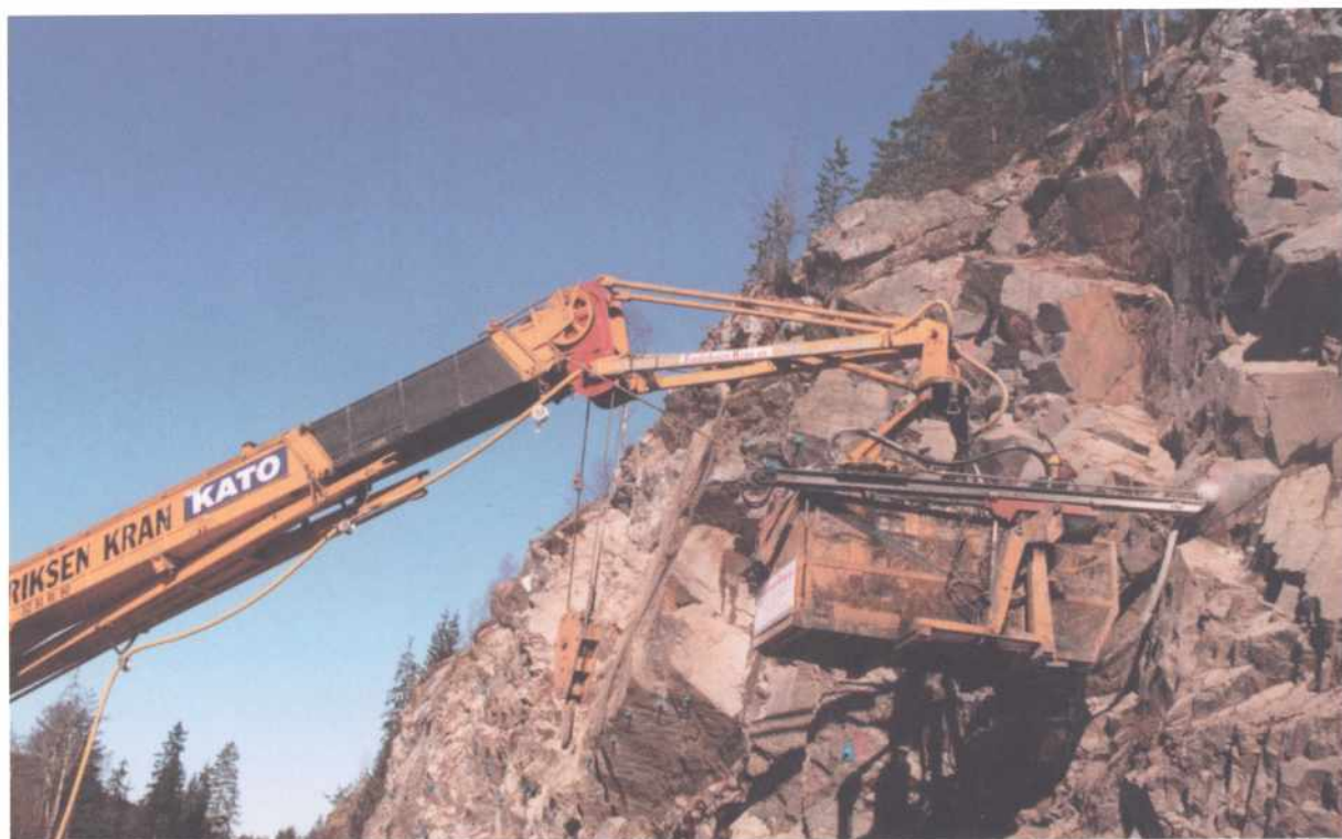
Bolting fra krankorg
