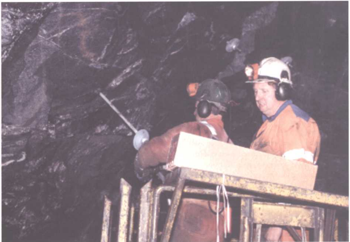
Montering av polyesterforankret bolt. (Foto: H. Berg)
