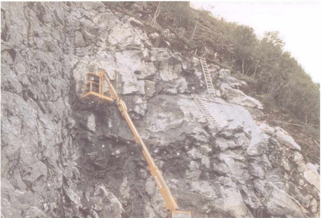
Boltesikring fra krankorg i fjellskjæring. (Foto K. B. Pedersen)
