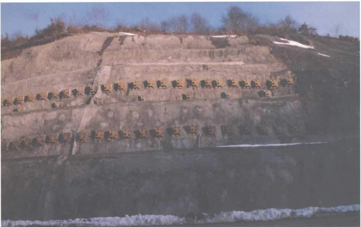
Bolting med stangstag i skjæring. (Foto: K.B. Pedersen)
