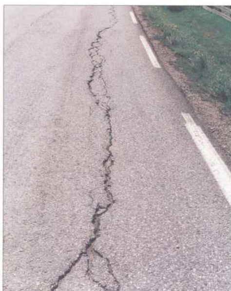
Kantsprekk, alvorlighetsgrad H
