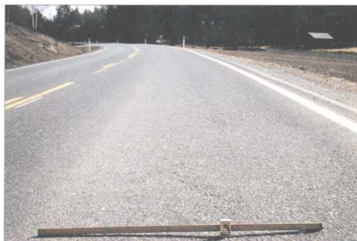
Spor pga. piggdekkslitasje, Alvorlighetsgrad M
