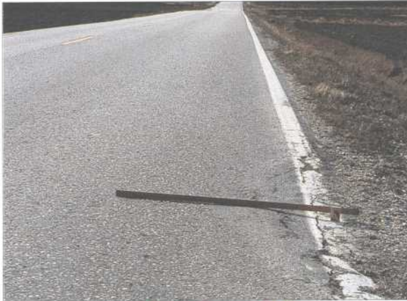
Kantdeformasjon, Alvorlighetsgrad M
