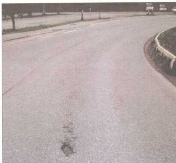
Slaghull, Alvorlighetsgrad L
