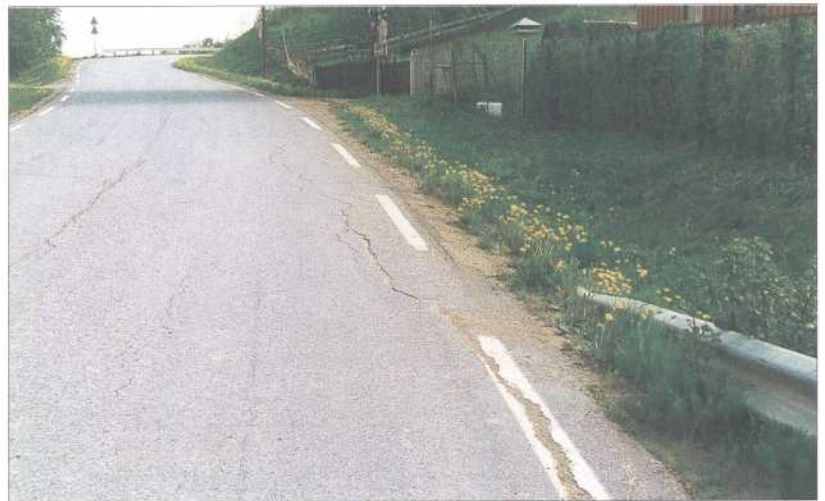
Figur 6 Smal vegskulder kan forårsake kantskader
