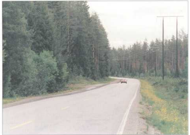
Ujevnt lengdeprofil, Alvorlighetsgrad M
