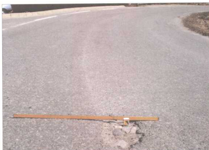
Slaghull, Alvorlighetsgrad M
