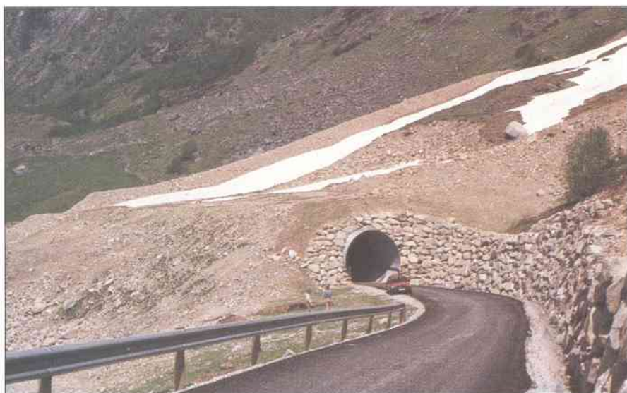
Figur 2.8 Rørtunnel kombinert med tørrmurer ved portalene. (Foto: H. Norem).
