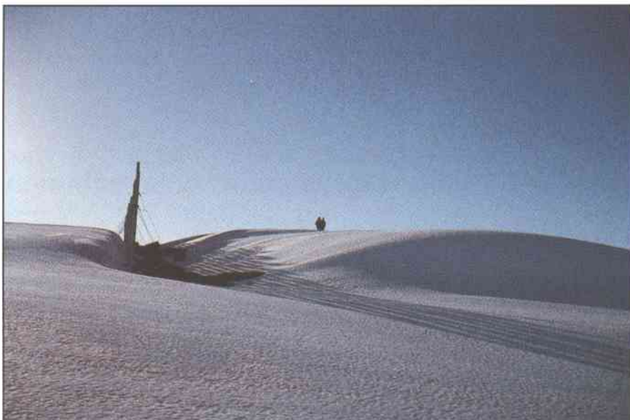
Figur 3.15 En effektiv snøskjerm skal samle snøen i god avstand fra skjermen, og snøansamlingen under og på vindsiden av skjermen skal være minst mulig. (Foto: I. Tøndel).
