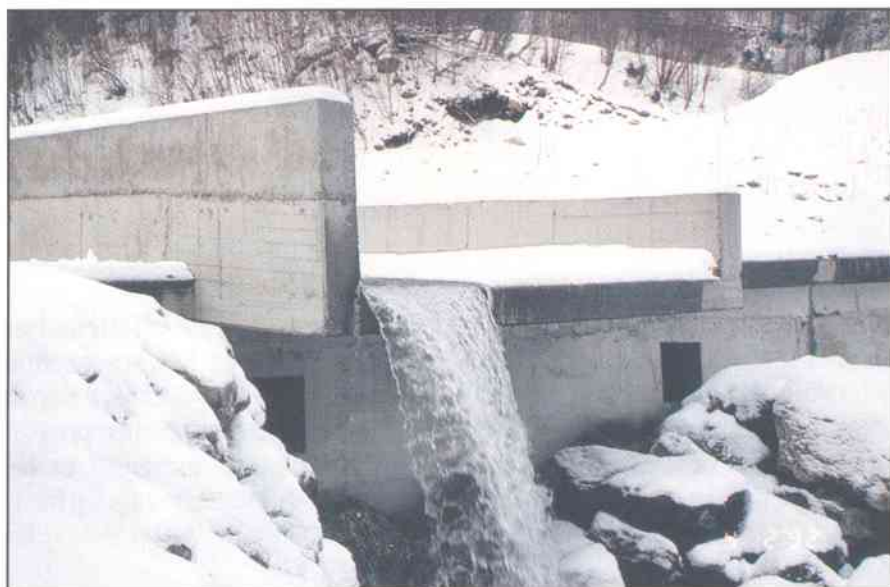
Figur 2.7 Eksempel på skredoverbygg med høy ledemur og dreneringsvannet ført i renne over overbygget. (Foto: H. Thorbergsen).
