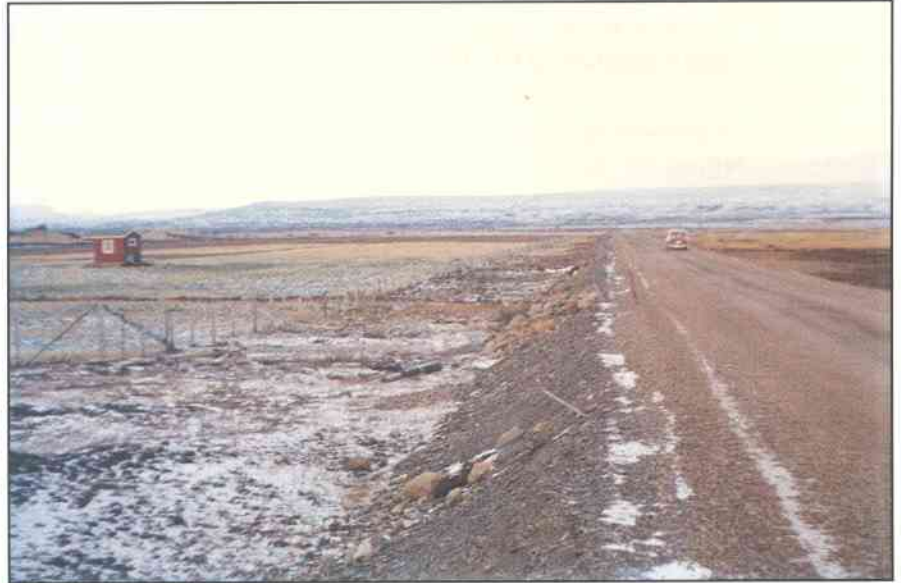
Figur 3.14 Foto av en liten bu som har ført til flere vegstenginger på Rv. 98, Vadsø - Vardø.
