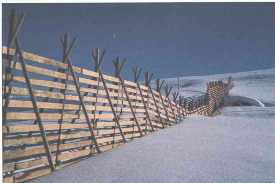
Figur 3.18 Snøskjerner er mest effektive når de står normalt på vindretningen og følger rygger i terrenget. Ved kryssing av forsenkningen burde denne skjermen vært forhøyet.
