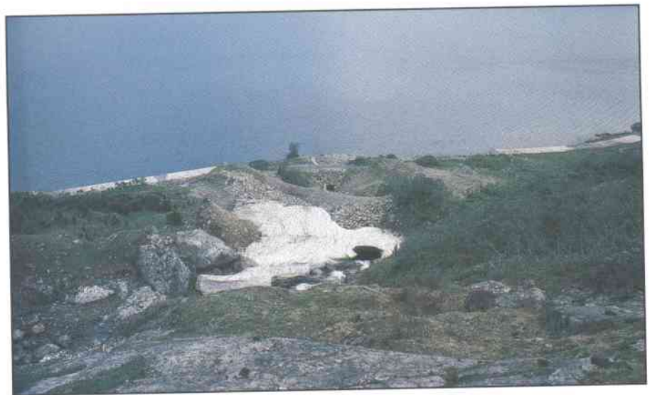
Figur 2.21 Rv. 550, Velure, Hardanger. Eksempel på kombinasjon av skred-overbygg, ledevoll, fangvoll og bremseskjegler. (Foto: H. Norem).
