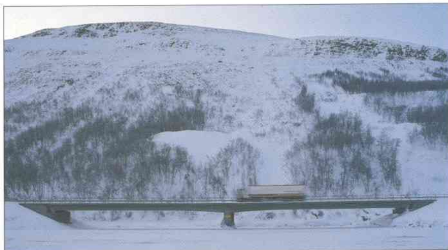
Figur 2.9 Bru bygget over et skredløp. (Foto: Kolbeinsens Foto).
