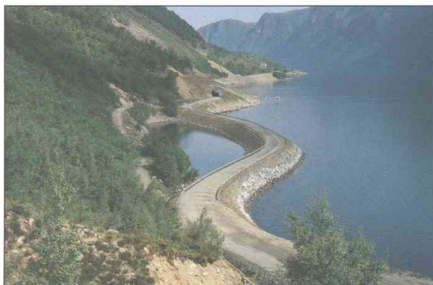
Figur 2.22 Skredsikring av Fv. 65, Standal - Festøy. (Foto: H. Norem).
