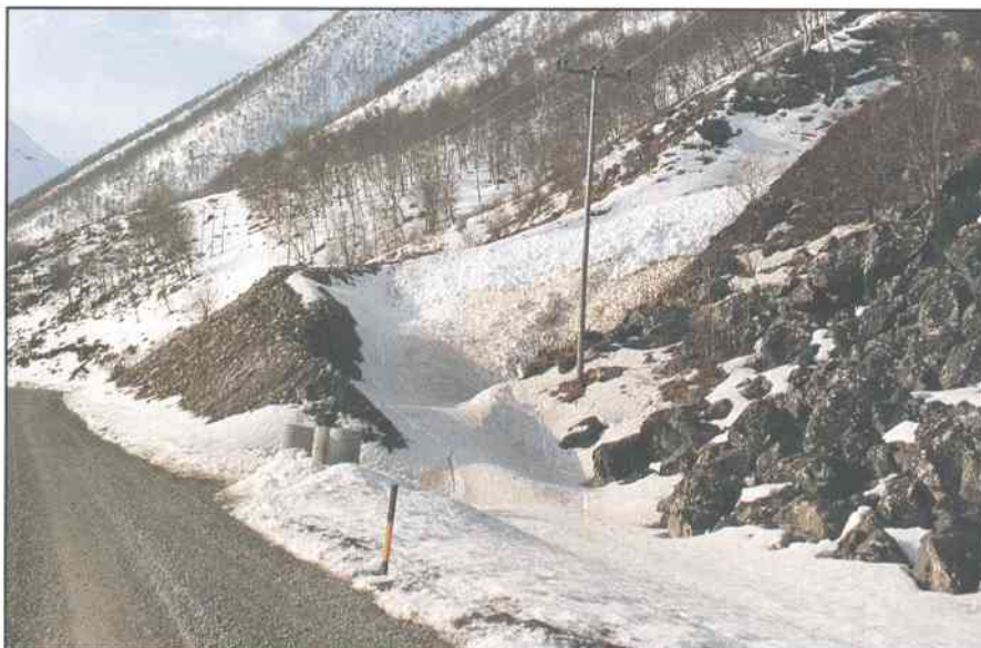
Figur 2.15 Ledevoller kan brukes som separate sikringstiltak ved å endre skredets retning parallelt med vegen. (Foto: A. Hustad).
