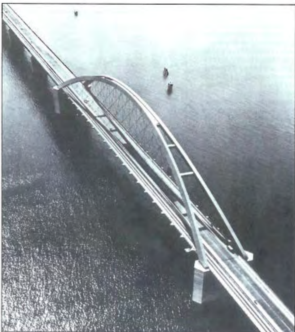
Fehmarnsund bru, Tyskland, 1963. Kombinert bil- og jernbanebru med fin markering av seiløpet. Fra: H. Wittfoht «Bridges», side 60.
