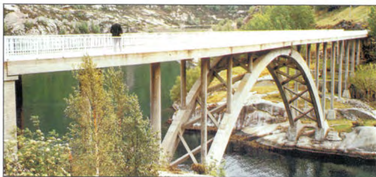
Leversund bru, Sogn og Fjordane, 1964. Buekonstruksjonen gir brua eleganse, men det blir en «skog» av søyler i sidespen- nene.
