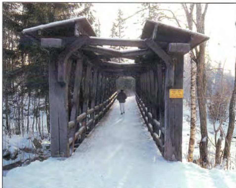
Finna bru, Oppland, 1868. Brua har halvøst tak som dekker konstruksjonen. Brua ble flyttet fra Vågå til Lillehammer i 1934.
