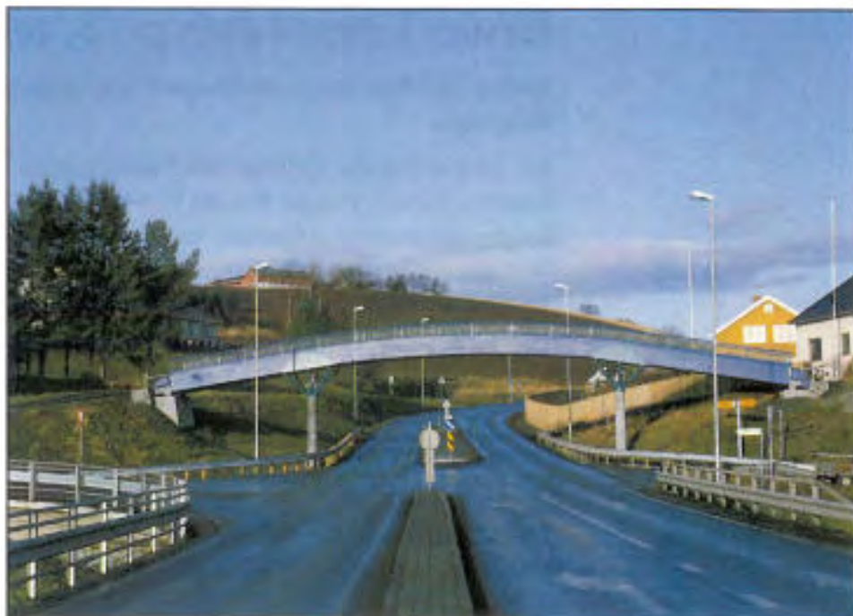
Strømmen bru, Nord-Trøndelag, 1958. Harmonisk og vakker bru med særpreg. Den åpne konstruksjonen markerer seg godt i omgivelsene og gir tettstedet Straumen sin identitet. Pilarene og rekkverket over landkaret burde imidlertid vært gitt samme omtanke som landkarene.
