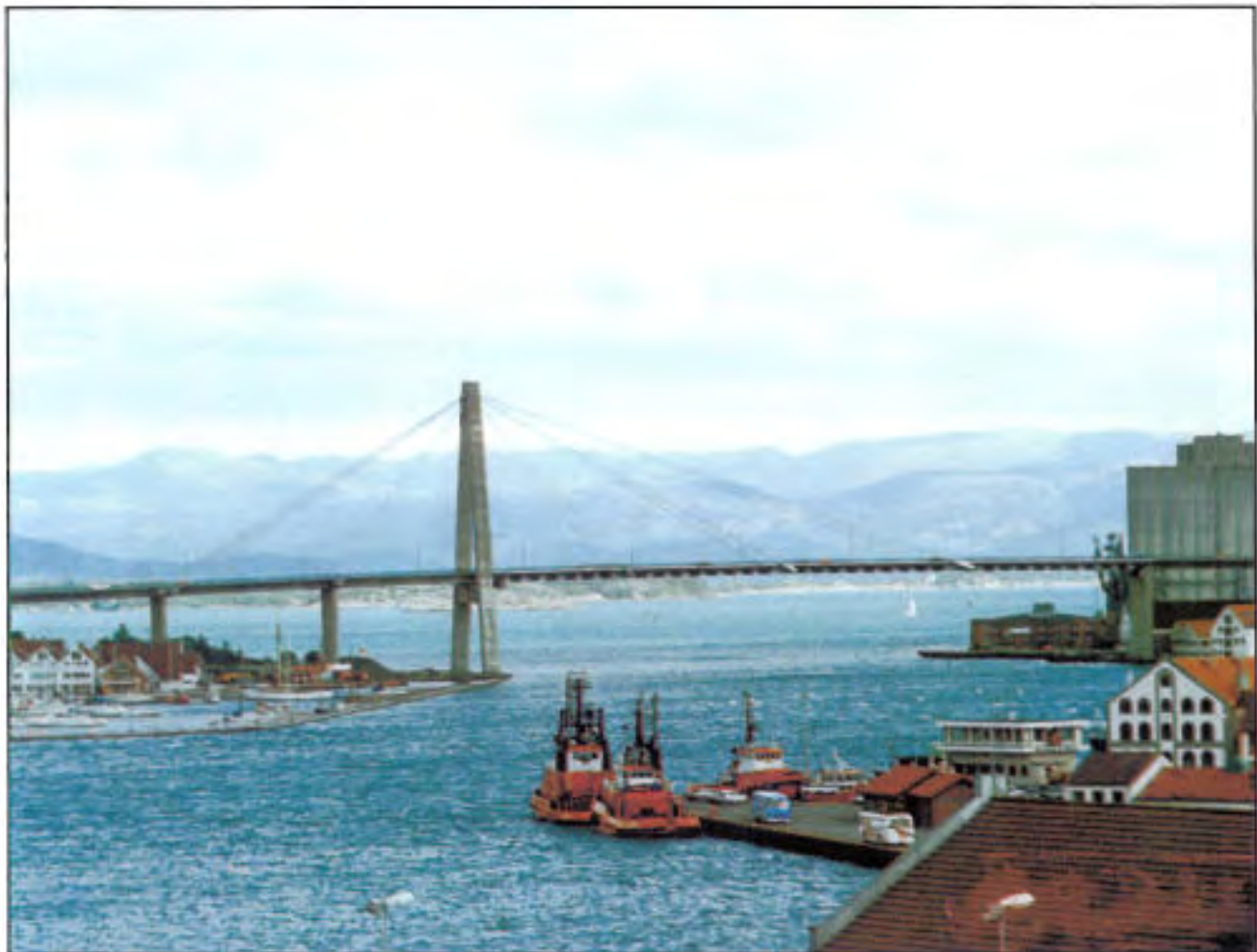
Strømstein bru, Stavanger, Rogaland, 1977. Skråstagbru med ensidig tårn skaper balanse mot siloanleggene til høyre. Noe høyere tårn over kabelfestene ville gitt brua økt eleganse
