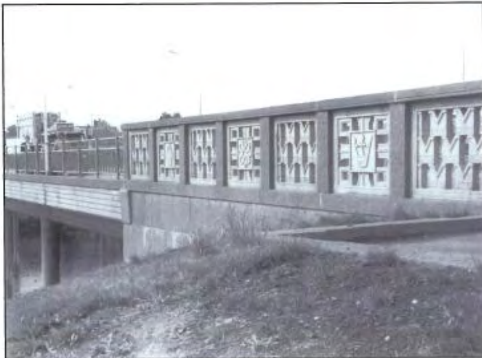
Elgeseter bru, Trondheim, Sør-Trøndelag, 1951. Rekkverksdetalj på bru for lav hastighet og fotgjengere.
