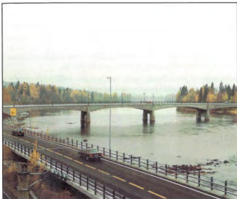
Elvebredden bru, Kongsvinger, Hedmark, 1991. (I forgrunnen). Kjørestærkt rekkverk. Rekkverket er såpass åpent at man virkelig kan se Glomma, og ikke bare rett inn i en førings-skinne.
