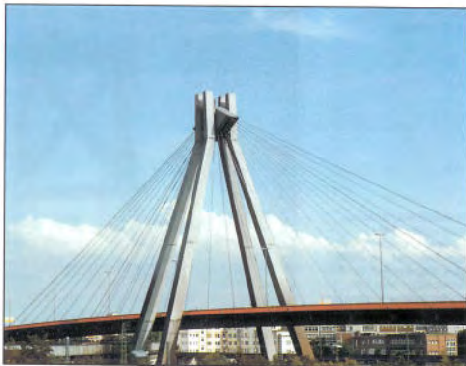
Bru over jernbaneområde, Ludwigshafen, Tyskland. Konstruksjonen er symme- trisk om tårnet (ingen «back-stay-kabler»).
