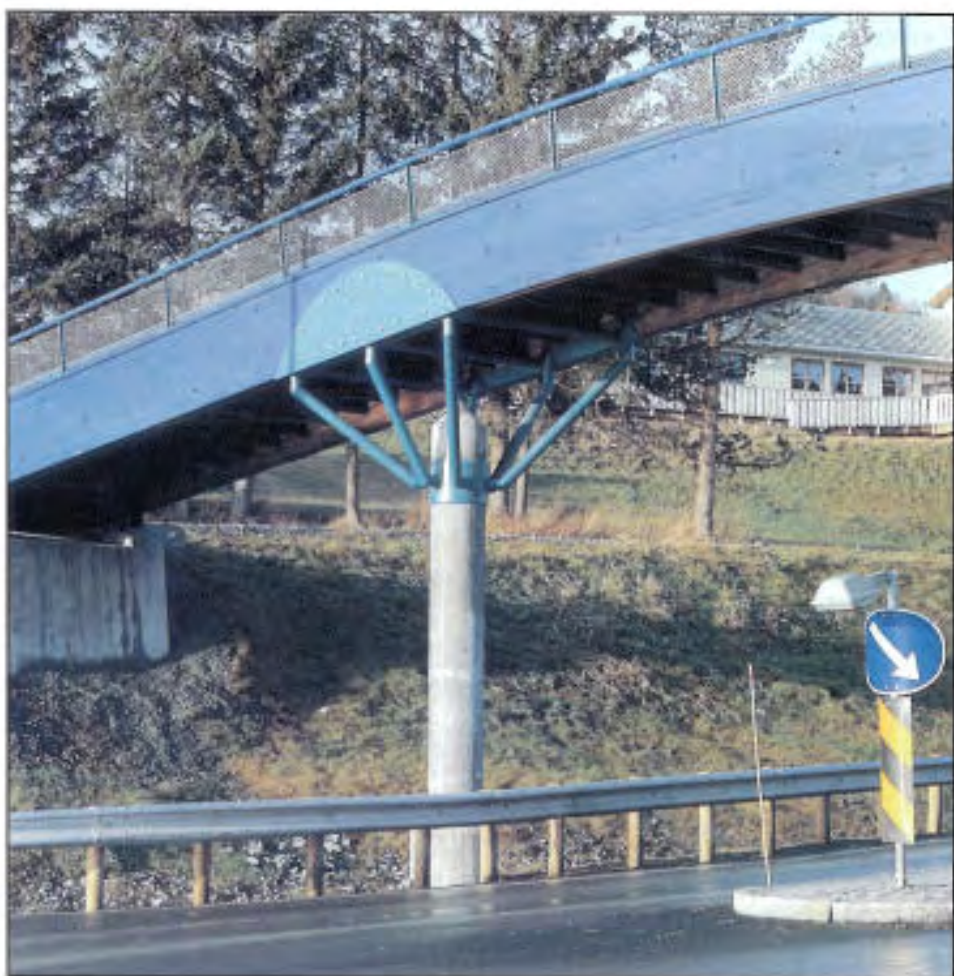
Limtrebru i Børse, Sør-Trøndelag, 1992. Møtet mellom pilar og limtretrager er vesentlig for bruas uttrykk.
