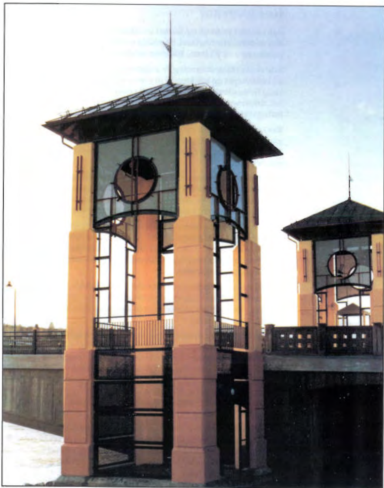
Gjemselund bru, Kongsvinger, Hedmark, 1991. Tårnene på Gjemselund bru har først og fremst en formmessig begrunnelse som en avslutning og markering av brua. I tillegg er de benyttet som trappetårn. Foto: Amund Sjøvik
