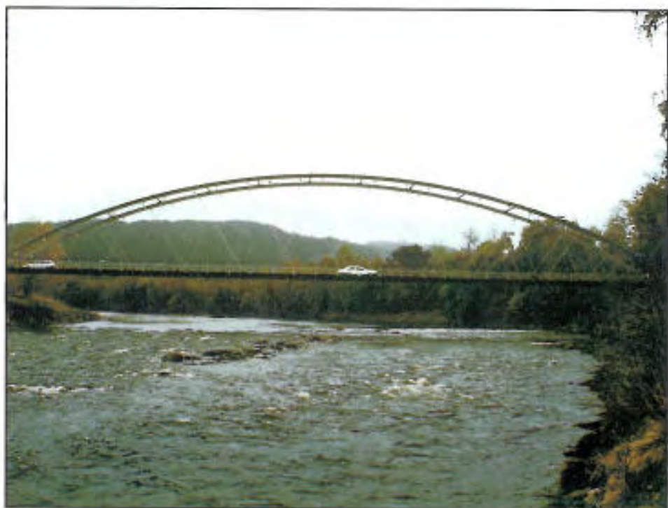
Håkkadal brua over Steinkjerelva, Nord-Trøndelag, 1962. En lett og elegant bukonstruksjon.
