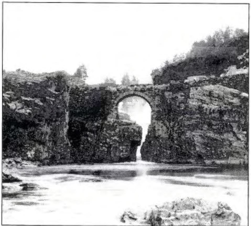
Holland bru, Sauda, Rogaland, 1867. Inntrykket skjemmes i dag av ei nyere stålbejelkebru bak og over den gamle brua. Kommunen har planer om istandsetting av den gamle brua, riving av stålbejelkebrua og bygging av ei ny bru ovenfor fossen og ute av syne.
