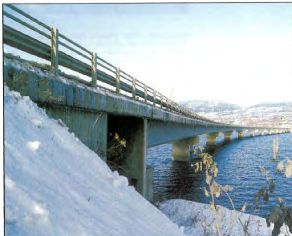
Lillehammer bru, E6, Oppland, 1984. Brua er 550 m lang og ligger svært lavt over vannflata og danner en demning over Gudbrandsdalslågen. Linjepålegget er en ren fortsettelse av vegens. Dette oppleves ikke som ei bru. Foto: Bjørn Hjeltnstad
