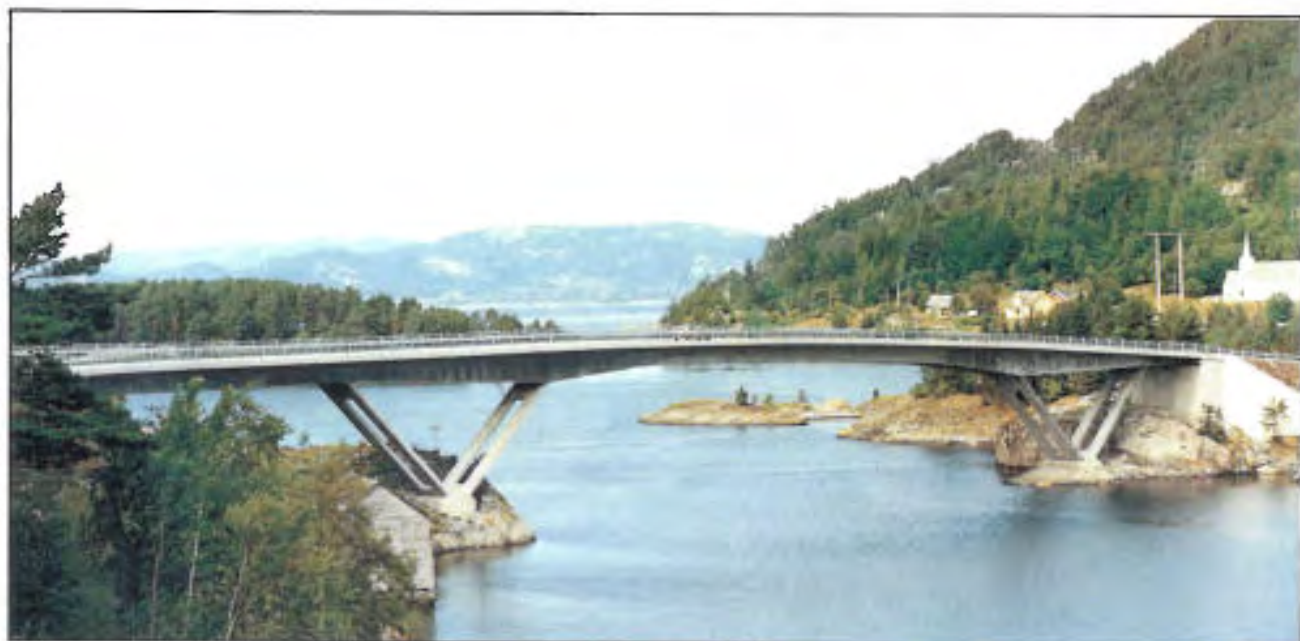
Grunnasundet bru, Hordaland, 1987. Denne pilarutformingen blir meningsløs når det ene sidespennet er så knapt. De skrå vingene på det dominerende landkaret er også med på å gi et uryddig helhetsinntrykk.
