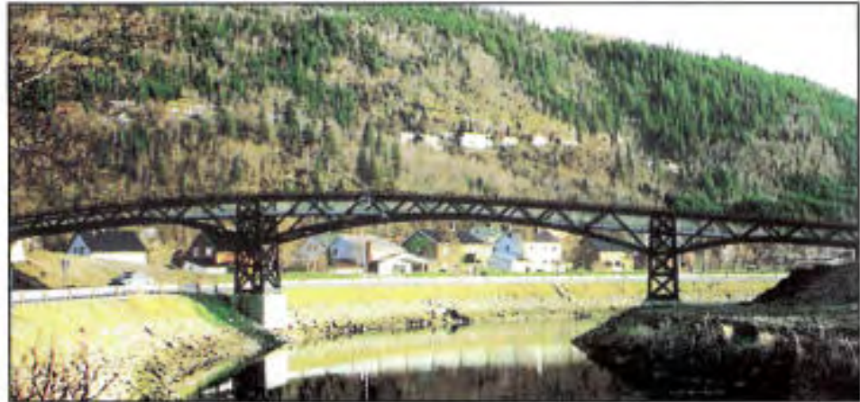
Dolstad gangbru, Mosjøen, Nordland, 1991. Brua ligger i et meget spesielt bygningsmiljø, og materialbruk og fargesetting er brukt bevisst for å gi tilknytning til Dolstad kirke og bygdetunet som ligger ved siden av. Fagverkskonstruksjonen er en del av bruas estetikk. Foto: Brynjør Berg
