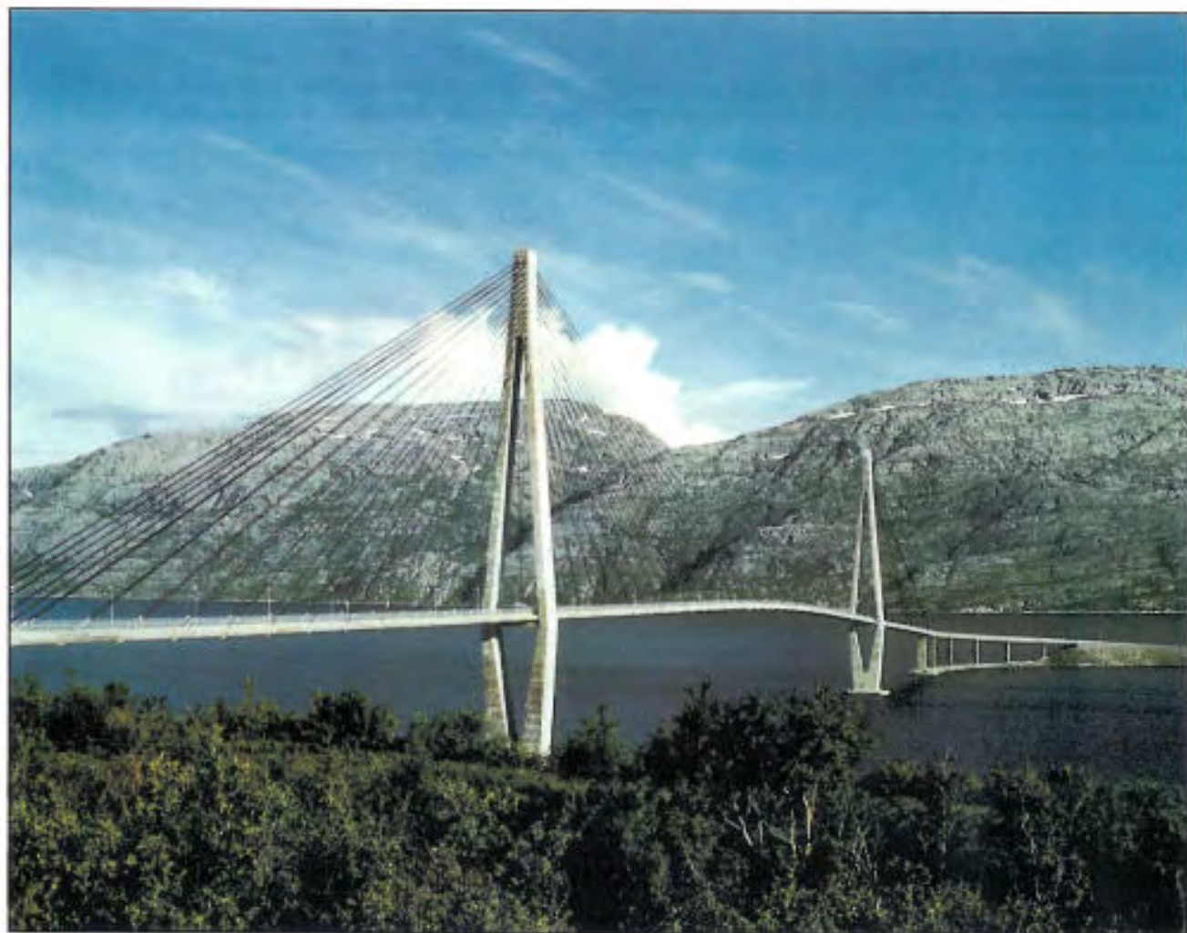
Helgelandsbrua, Nordland, 1991. Konstant vertikalradius mel- lom tårnene hadde resultert i en enda mer elegant bru.
