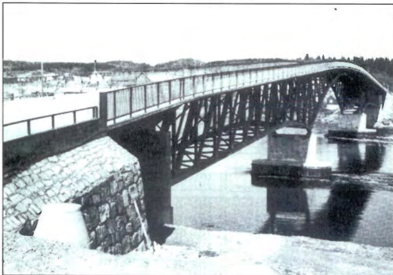
Strømmen bru, Nord-Trøndelag, 1958. Harmonisk og vakker bru med særpreg. Den åpne konstruksjonen markerer seg godt i omgivelsene og gir tettstedet Straumen sin identitet. Pilarene og rekkverket over landkaret burde imidlertid vært gitt samme omtanke som landkarene.
