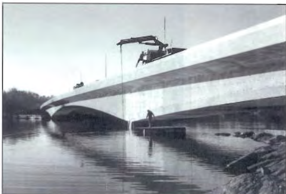
Torpevika bru, Hordaland. Hovedformen er elegant, men brua ligger lavt i forhold til konstruksjonshøyden, og brua blir tung. En markering av pilarene ville gjort at brua virket noe lettere.
