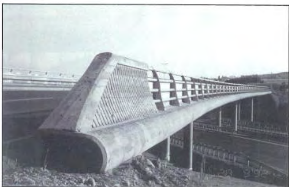
Deglum bru over E6 ved Hamar, Hedmark, 1992. Foto: Ole R. Østby
