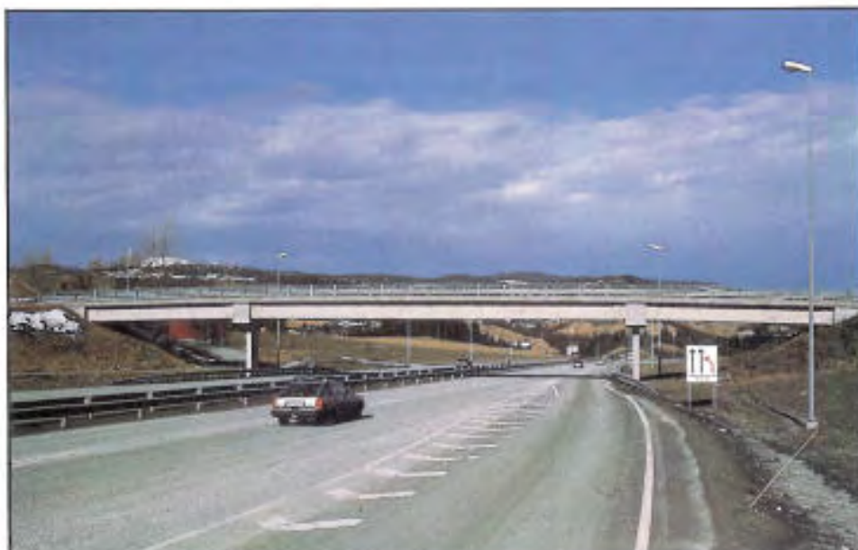
Overgangsbru over E6 på veg inn til Trondheim. Pilarene er altfor tynne i forhold til den tunge overbygningen. Litt gunstigere vertikalkurvatur og slankere bru kunne vært ønskelig.
