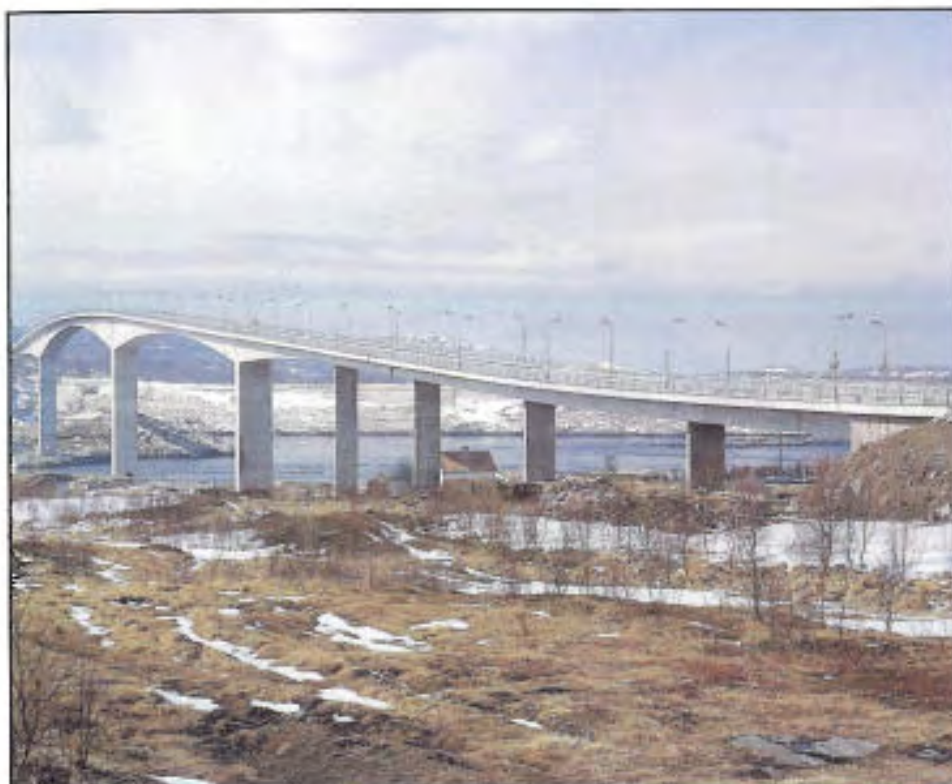
Saltstraumen bru, Nordland Brua har en linjeføring som gir konstruksjonen spenst. På grunn av bruas størrelse, markerer den seg klart i omgivelsene.
