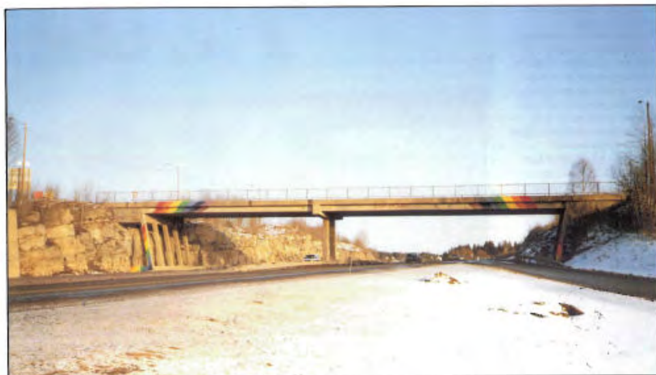
Bru over E18, Liertoppen, Buskerud. Utradisjonell fargesetting etter konkurranse. Et friskt innslag, men det må generelt advares mot å lage effekter.
