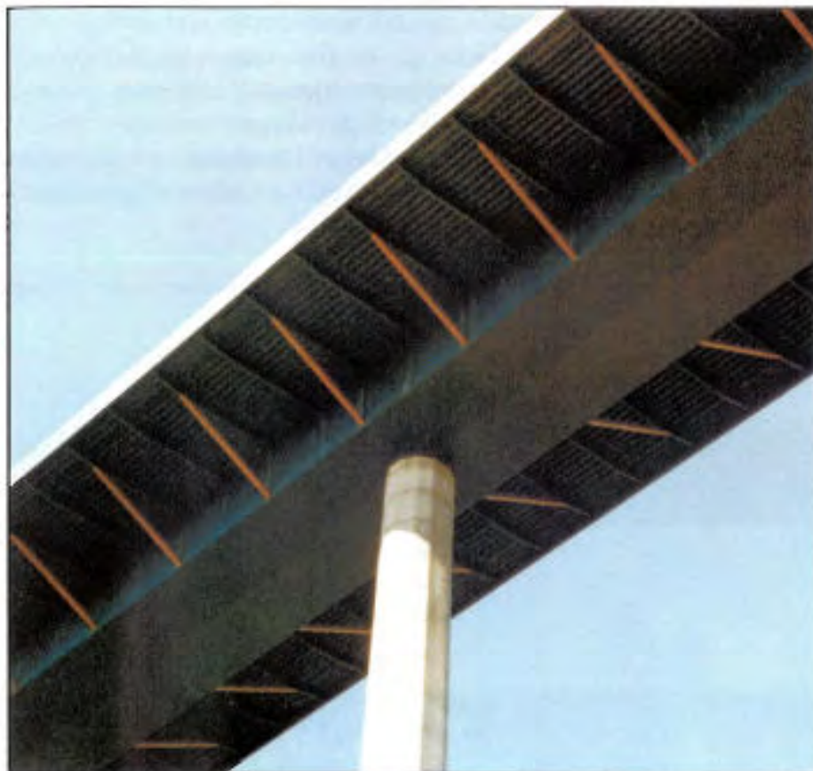
Neckartal-brua, Weitingen, Tyskland. Positivt eksempel på at også undersiden av ei bru er gitt omtanke.
