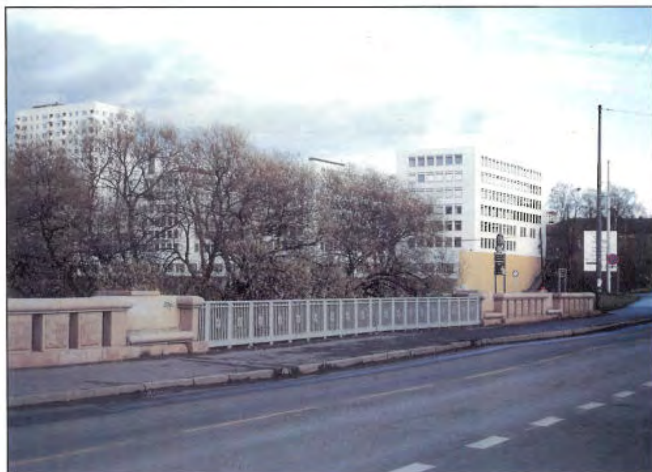
Rekkverk på Sanner-brua, Oslo, 1914. Landkarene er markert med en endring i rekkverksutformingen, der benker i samme materialet er integrert.
