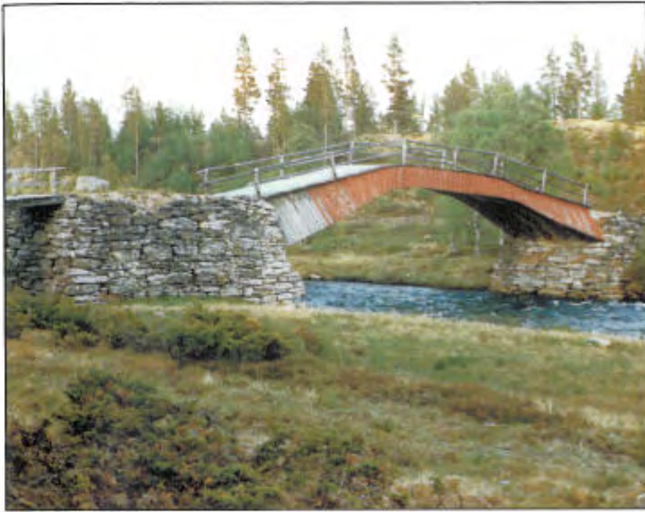
Grimsa bru ved Fallet i Foll- dal, Hedmark, ca. 1870. Res- taurert ca. 1970. Sprengverksbru i tre, en typisk konstruksjon for mange gamle norske trebru- er.
