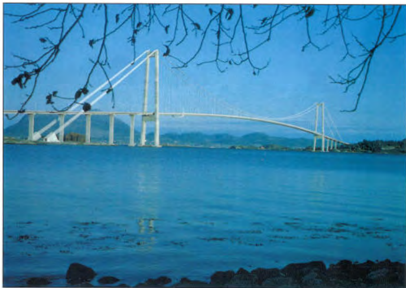
Gjemnessundbrua. Kristiansunds fastlandsforbindelse, Møre og Romsdal, 1992
