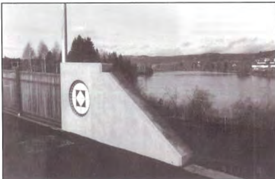
Avslutning av rekkverk på Kurudsand bru, Kongsvinger, Hedmark, 1991.
