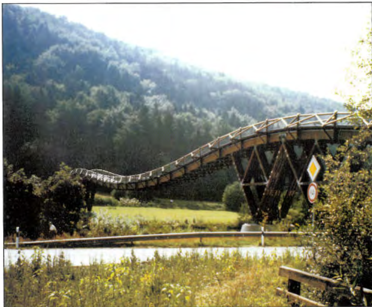
Gangbru i limtre over Main-Donau-kanal, 1991. Kontinuerlig strekkbåndkonstruksjon. Hovedspenn 73 m.
