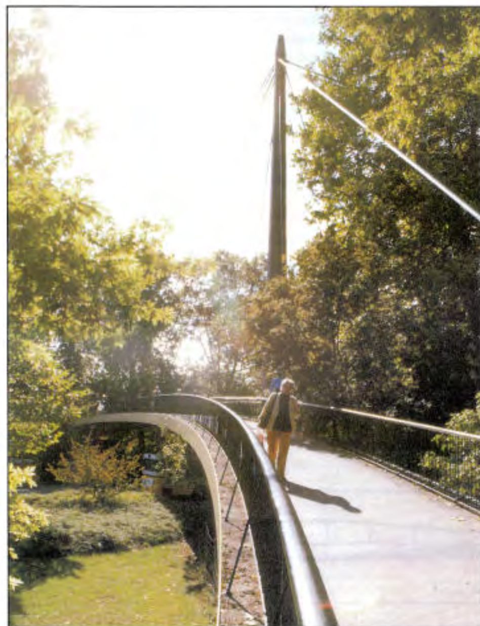
Schiller Steg, Stuttgart, Tyskland, 1961. Denne brua er utformet etter idealet om slanke konstruksjoner. Alle elementer viser den samme letthet og eleganse, som f.eks. transparente rekkverk med lys integrert i håndlista.
