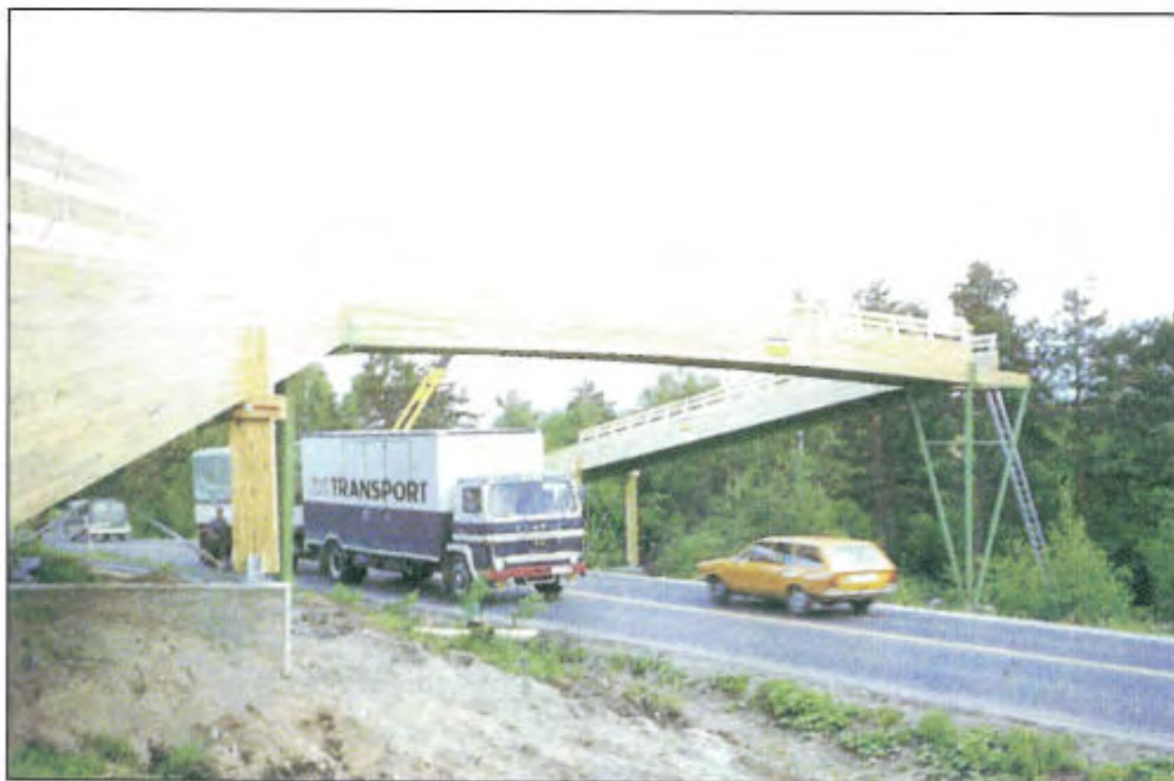
Gangbru over Fetveien, Skedsmo. Brua får en kantete form på grunn av at vette limtrebjelker er brukt der det kreves en smidigere linjeføring. Inntrykket er forsøkt rettet opp ved bruk av piler som er gitt en særegen utforming. Men det blir ikke godt. Foto: Moelven limtre «Limtreboka», side 57.
