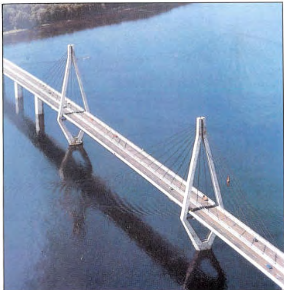
Færø bru, Danmark, 1985. Seilingsløpet er gitt en skråstagskonstruksjon. Resultatet er en sterk markering av brua som dominant faktor i landskapet.
