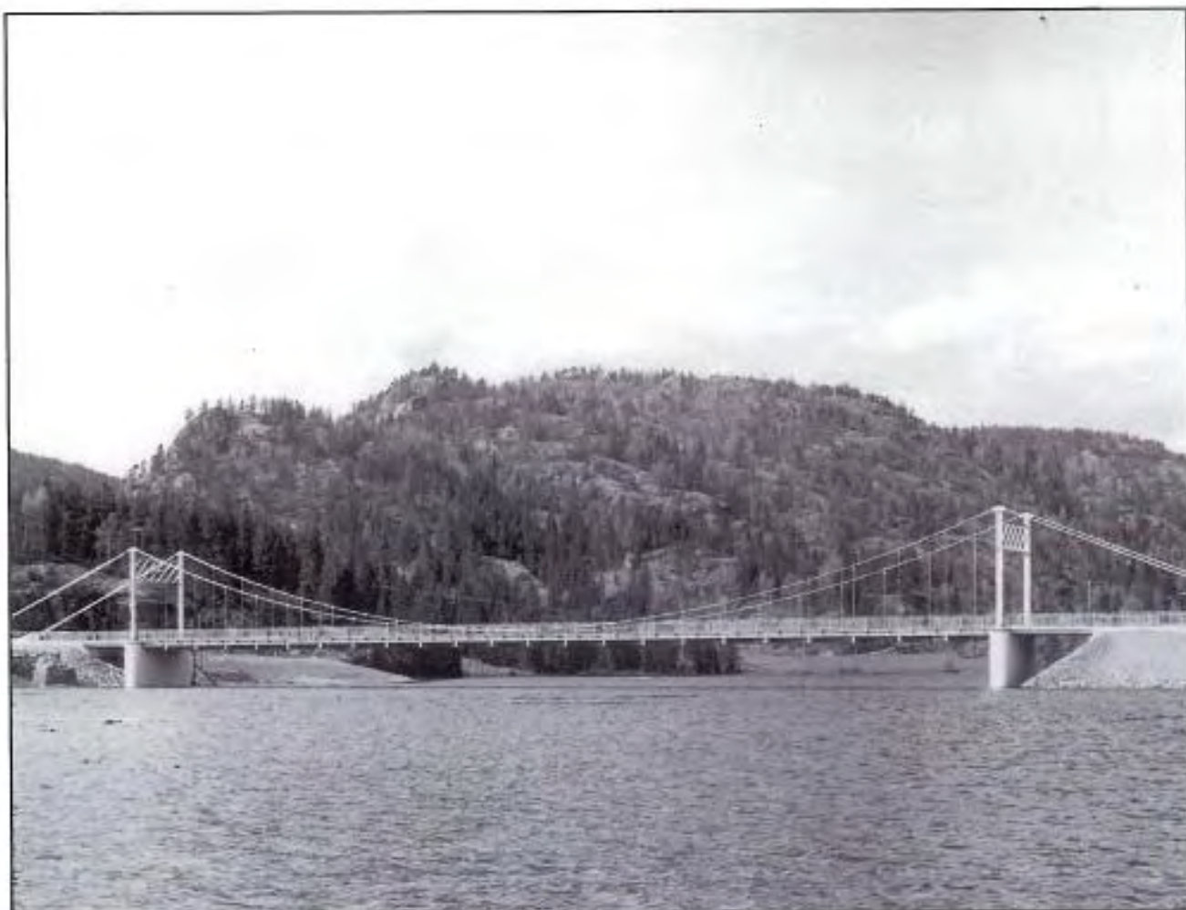
Stenlona bru, Birkenes, Aust-Agder, 1937. Tårnene er lave og gir et noe «brei-bent» inntrykk. Men brua har fine, bearbei- dte detaljer, som f.eks. rigelen mellom tårnene som er utført med et diagonalt rastermønster. Dessverre er også denne brua altfor kort, og ligger på skjemmende, lange fyllinger.
