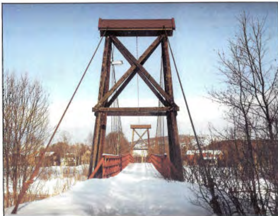
Stenlona bru, Birkenes, Aust-Agder, 1937. Tårnene er lave og gir et noe «brei-bent» inntrykk. Men brua har fine, bearbei- dte detaljer, som f.eks. rigelen mellom tårnene som er utført med et diagonalt rastermønster. Dessverre er også denne brua altfor kort, og ligger på skjemmende, lange fyllinger.
