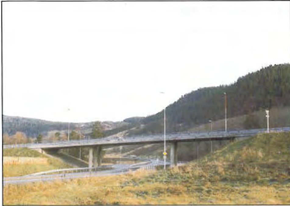
Overgangsbru på E65 ved Orkanger, Sør-Trøndelag, 1985.
