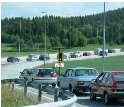
Figur 17 Anlegg for rampekontroll
