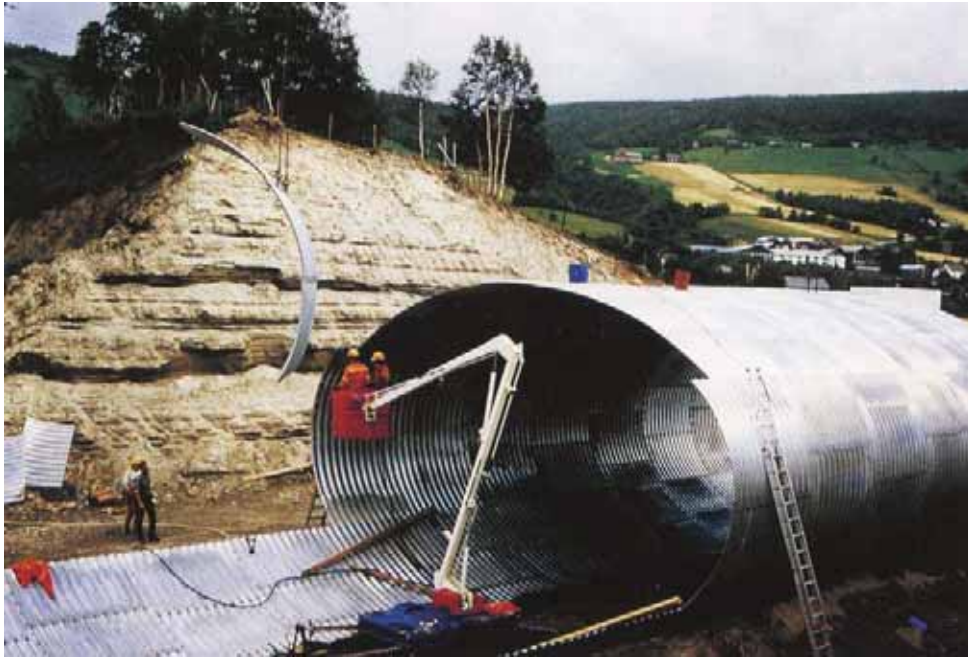
Figur 12. 25 Formonterte plater heises på plass.
