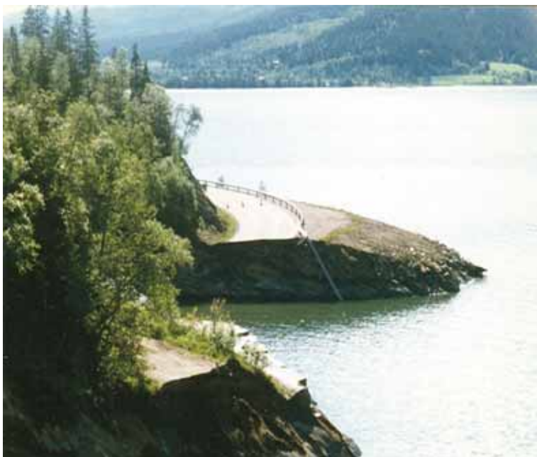
Figur 1.1 Bilde av skred ved E6 i Finneidfjord, Nordland
