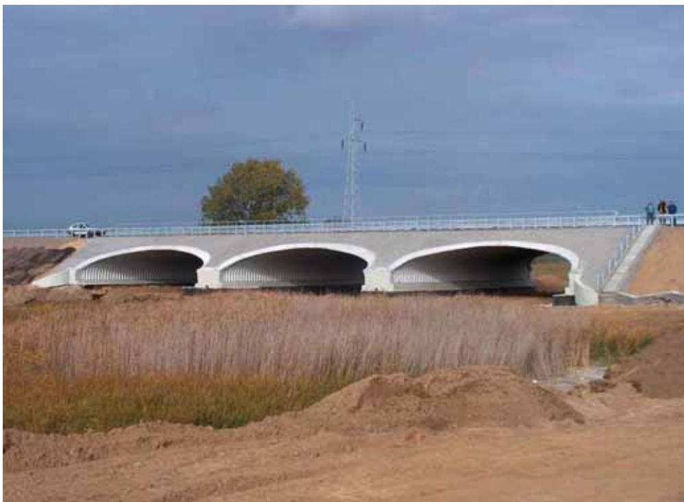
Figur 12. 7 SuperCor konstruksjon (Polen) Ståltykkelse 7 mm, overdekning 1,2 m, byggeår 2005.
