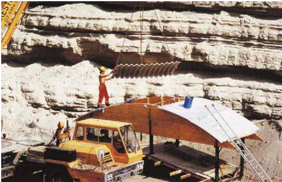
Figur 12. 26 Mal til formontering av plater.
