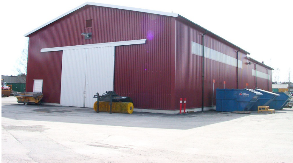
SAND- SALTLAGER VED SKIEN VEGSTASJON
