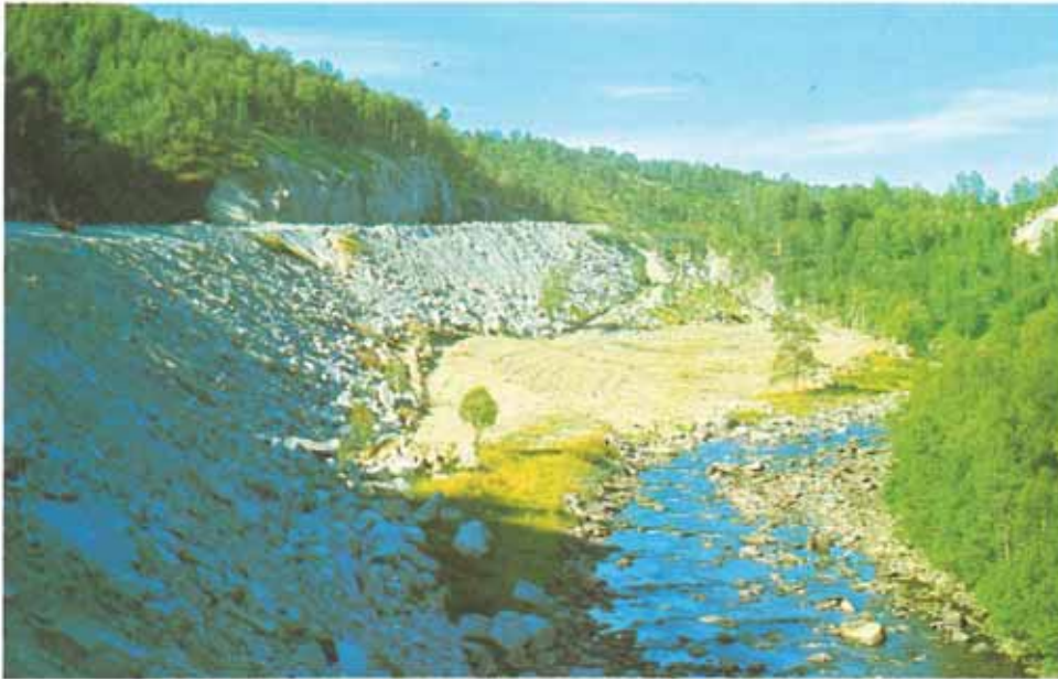
Dominerende steinfyllinger bør dekkes til.
