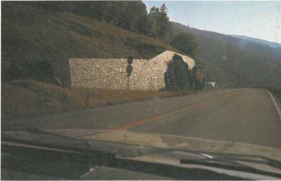
Mur av naturstein i fjellskjæring bør i materialer og farge stemme overens med fjellet i skjæringen.
