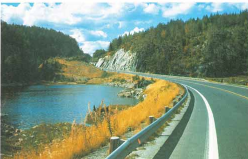
Bergrabben midt på bildet bryter en ellers ensformig fyllingsskråning.
