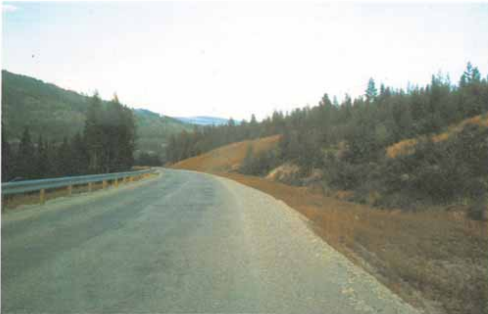
En god utforming av side-terrenget og en tilsynelatende effektiv revegetering. Normalt vil skogen komme inn på skråningen over tid.
