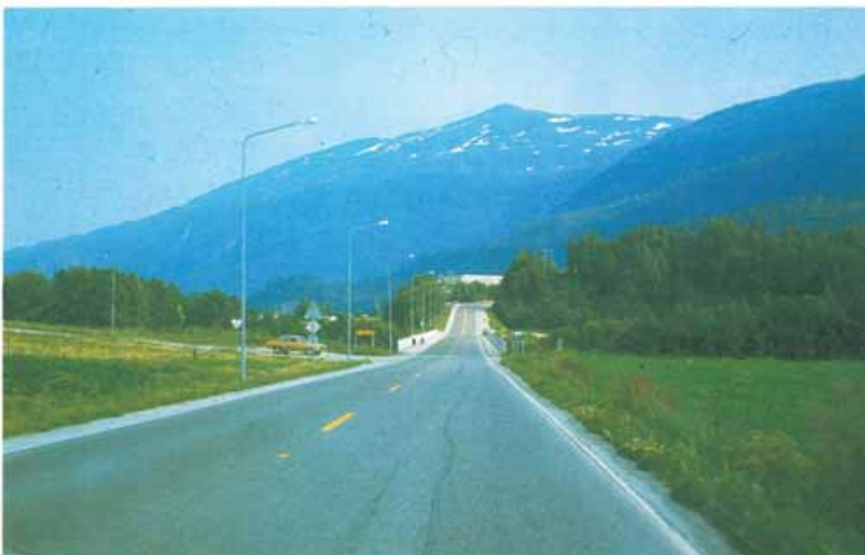
Brua forårsaker en knekk i vertikalprofilet.
