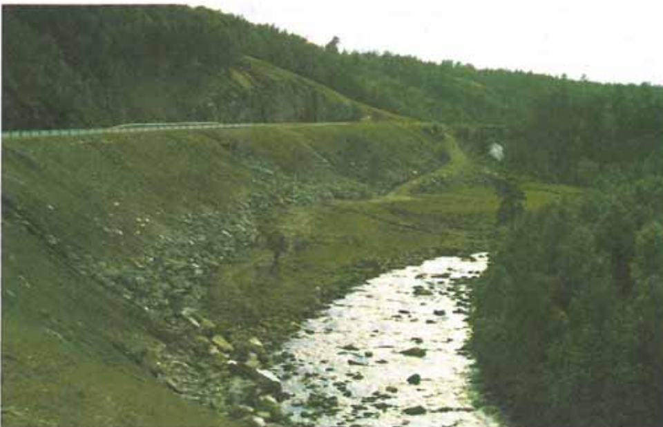
Etterarbeidene på det nærmeste fullført. Steinmassene har sortert seg under tippingen. Dette gjør det vanskelig å dekke hele fyllingen.
