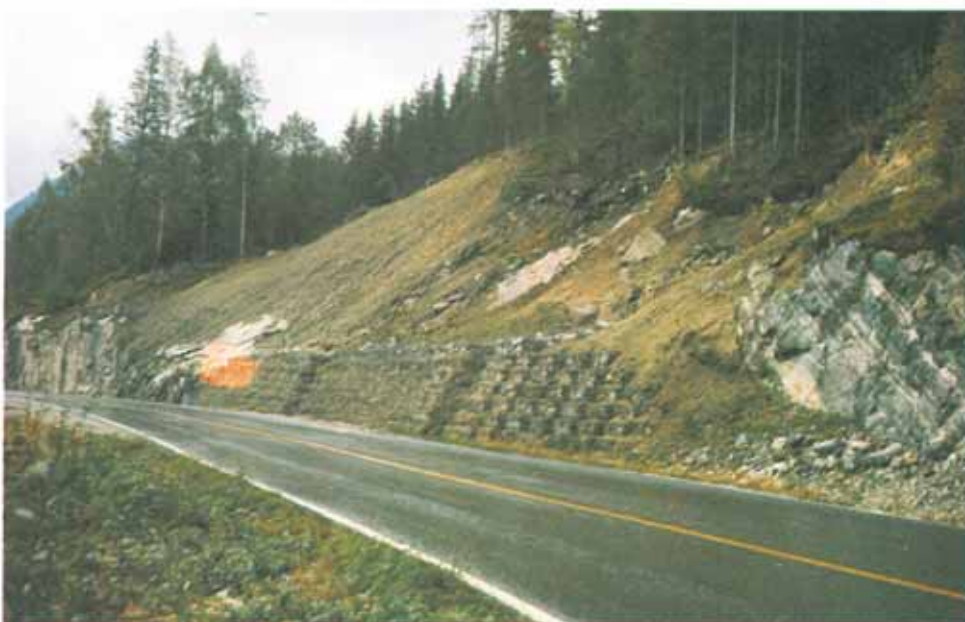
Støttemuren må stå i forhold til omgivelsene. Gabbioner gir her et lite tilfredsstillende helhetsinntrykk. Vegetasjonen kan få gabbionmuren til å henge bedre sammen med resten av skråningen.
