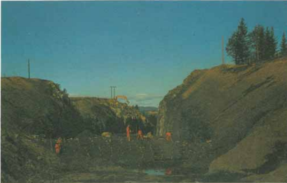
Øverste halvdel av skjæringen er her sprengt med helling 1 : 1.
