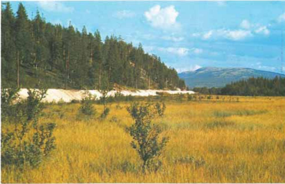
Eksempel på veg i randsone. Opparbeiding av sideterrenget kunne vært bedre.
