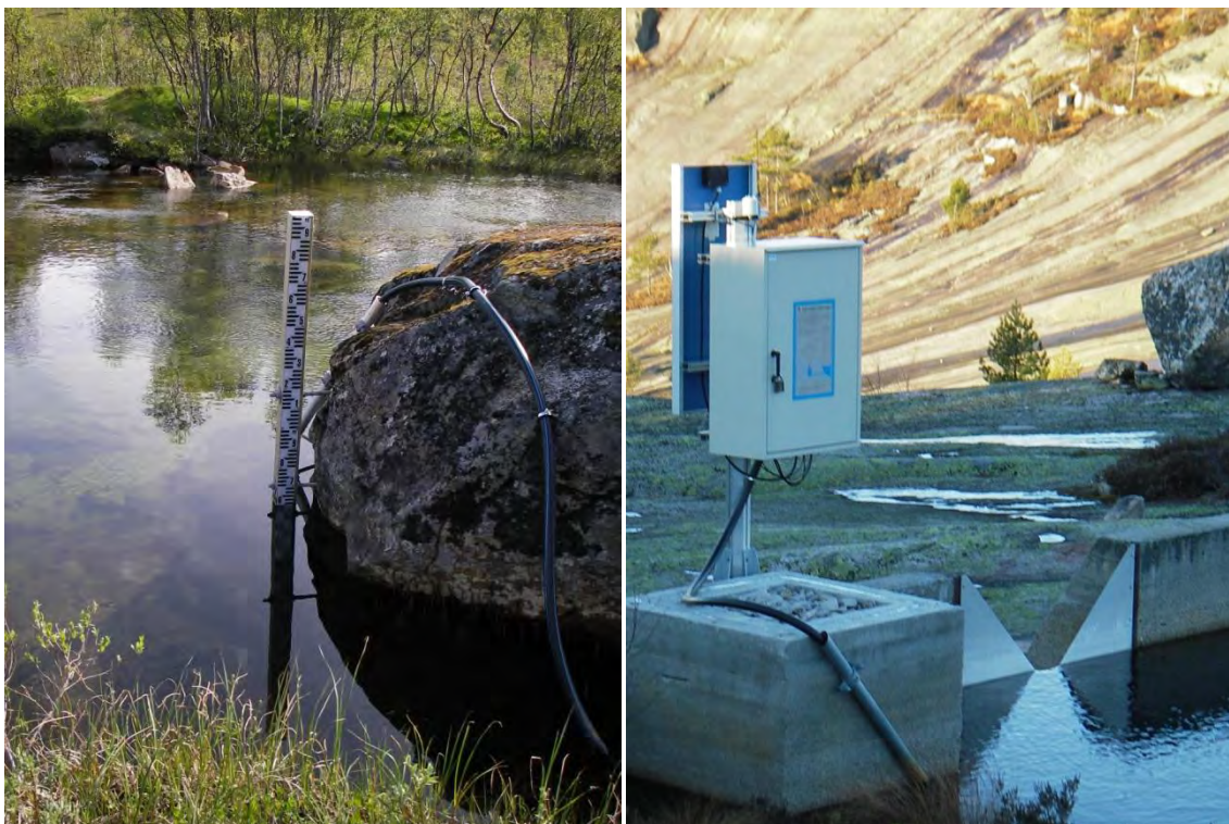
Fra venstre: Skala og trykksensor i elv, 197.10 Ersfjordelva. Målestasjon 19.47 Storgama med instrumentskap, solcellepanel, v-overløp og trykksensor lagt ut i vannet. (Foto: NVE-HHs stasjonsbildearkiv).
