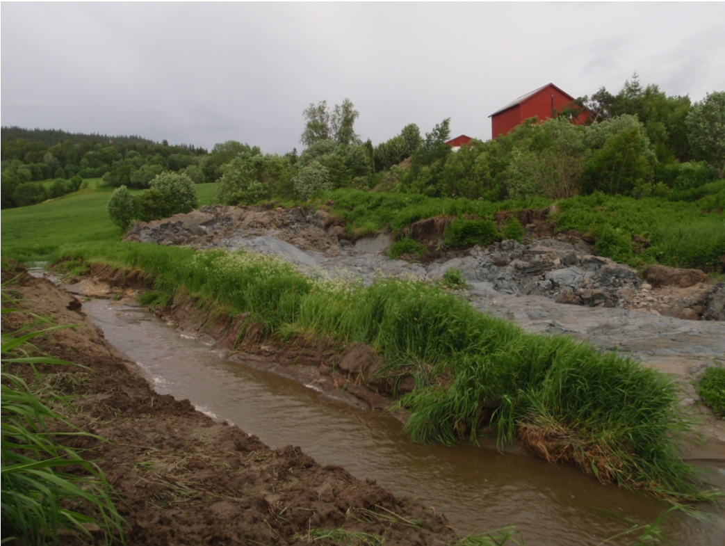
Figur 2 Nytt midlertidig elveløp gravd ut foran skredet
