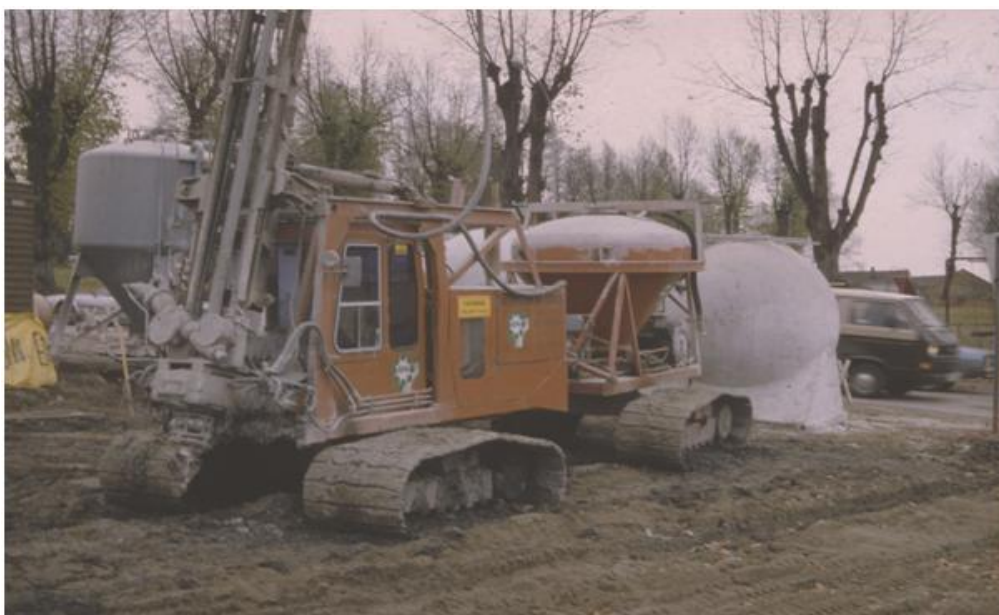
Figur 2.1: Viser stabiliseringsutstyr fra midten av 1980-tallet. Foto NGI.
